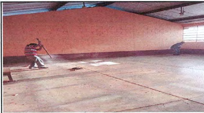
Foto 2: Sustitución de piso a piso de granito
