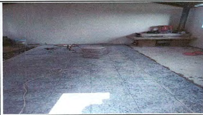
Foto 2: Sustitución de piso a piso de granito
