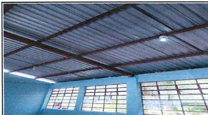
Foto 4: Sustitución de focos y plafoneras
