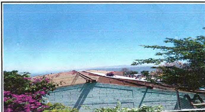
Foto 1: Sustitución de láminas
