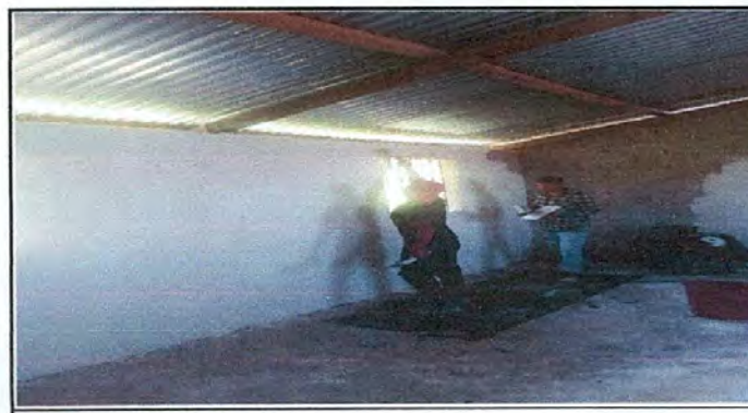
Foto 6: Repello de paredes
