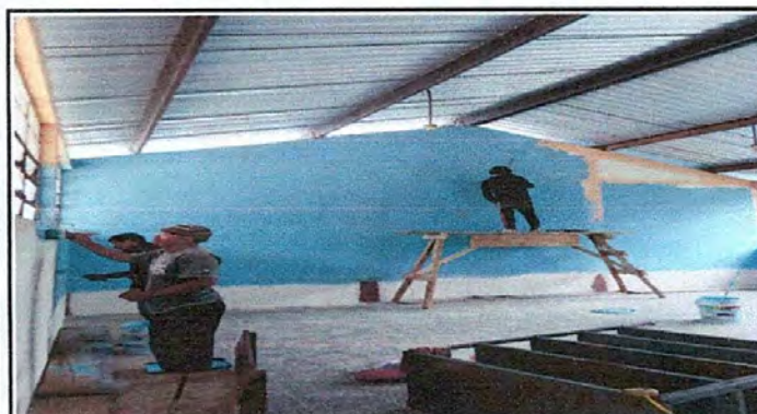
Foto 3: Pintura en paredes exteriores e interiores
