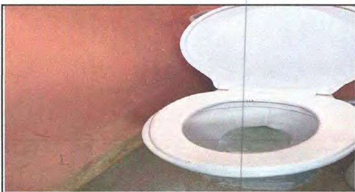
Foto 11: sustitución de inodoro ya están en malas condiciones por lo que se cambiaron.
