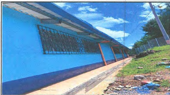
Foto 7: sustitución de canaletas ya están en mal estado por lo que se priorizó.
