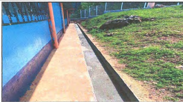
Foto 8: reparación de cuneta de concreto ya está en malas condiciones por lo que se priorizó.
