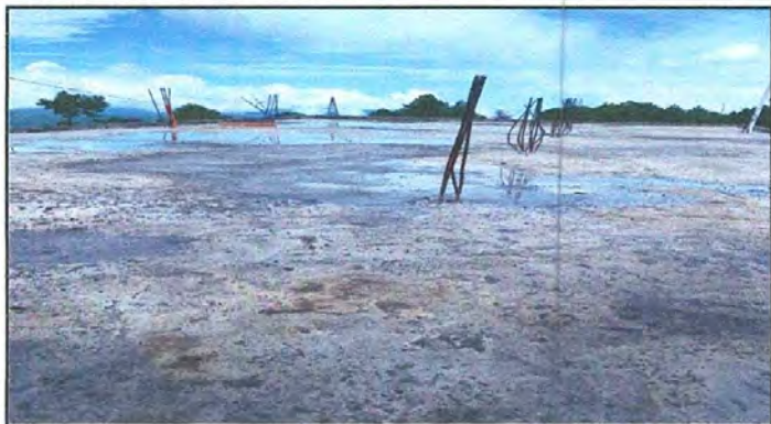
Foto 1: impermeabilización de losa de la Escuela ya está en malas condiciones, por eso se priorizó.
