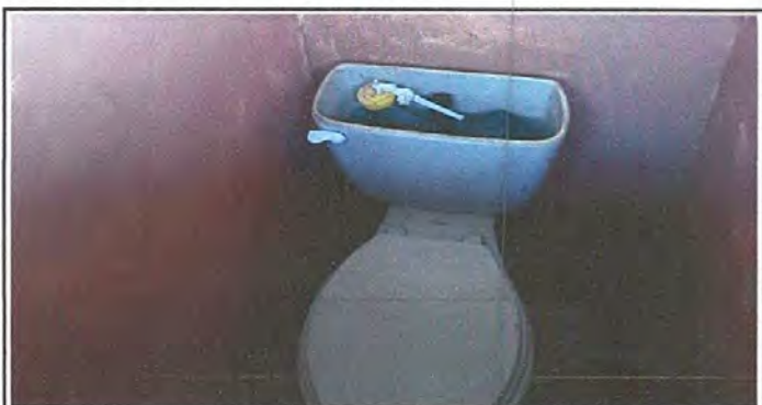
Foto 11: sustitución de inodoro ya están en malas condiciones por lo que se cambiaron.
