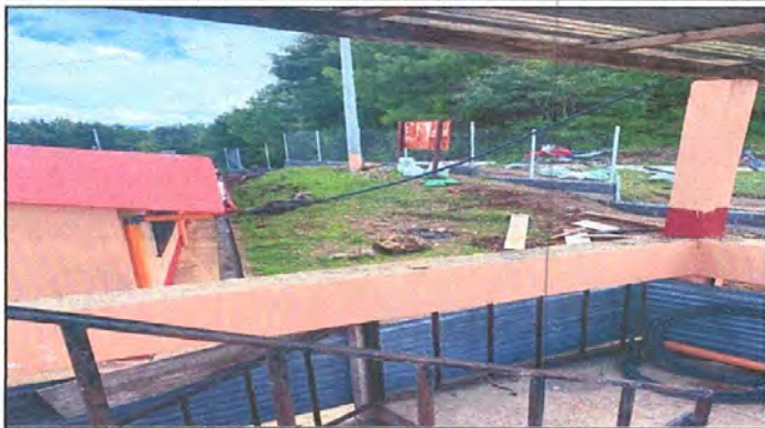
Foto 7: sustitución de canaletas ya están en mal estado por lo que se está sustituyendo.
