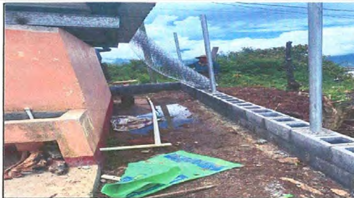
Foto 2: la malla se encuentra en mal estado por lo que se está cambiando.
