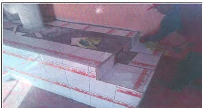
Foto 12: instalación de azulejo en estufa rural ya está en malas condiciones por lo que se está priorizando.
