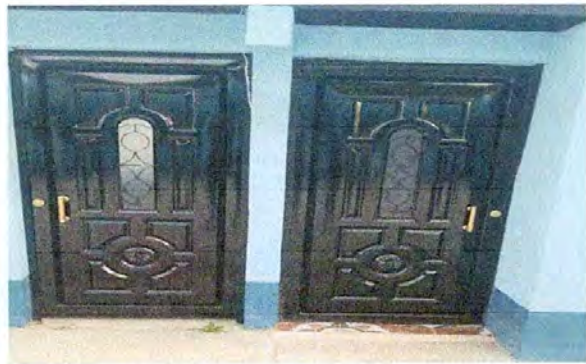
Foto1: Asi se finalizo el modulo 4 PUERTAS DE METAL, sustitucion de dos puertas de metal
