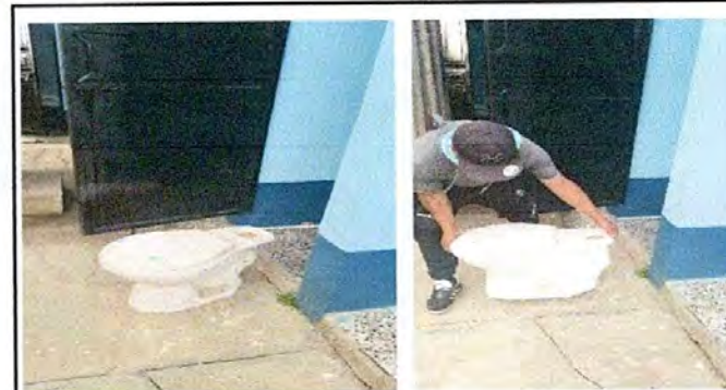
Foto 6: proceso de sustitucion de inodoro
