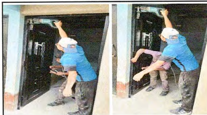
Foto 4: Proceso de la susticion de puertas
