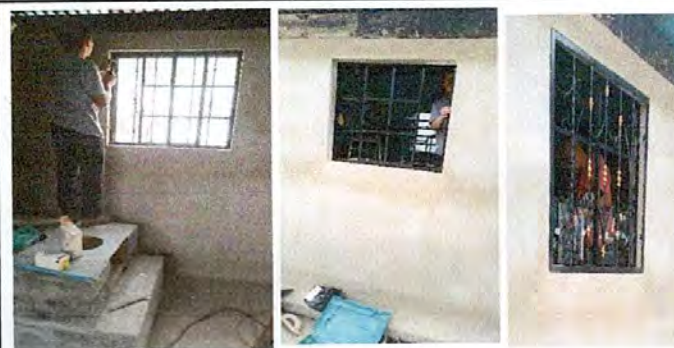
Foto 5: proceso de sustitucion de ventanas y balcon
