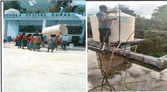
Foto 2: proceso de sustitucion de deposito de agua
