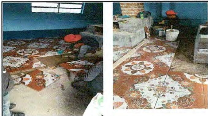
Foto1: Proceso de sustitucion de piso ceramico en la cocina
