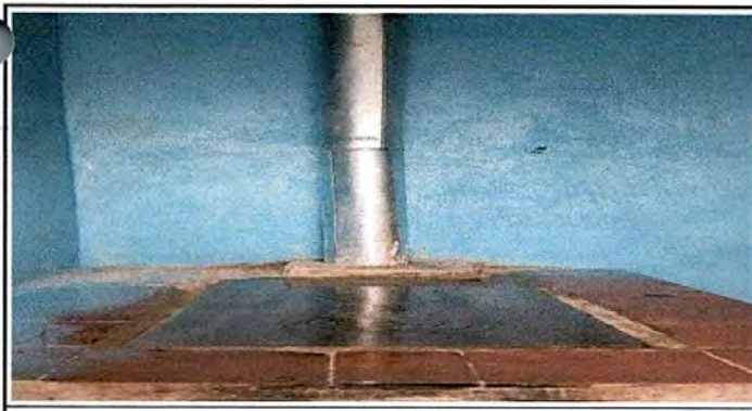
Foto 5: Instalación de plancha y chimenea de metal
