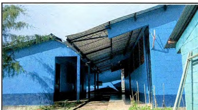
Foto 4: Aplicación de pintura
