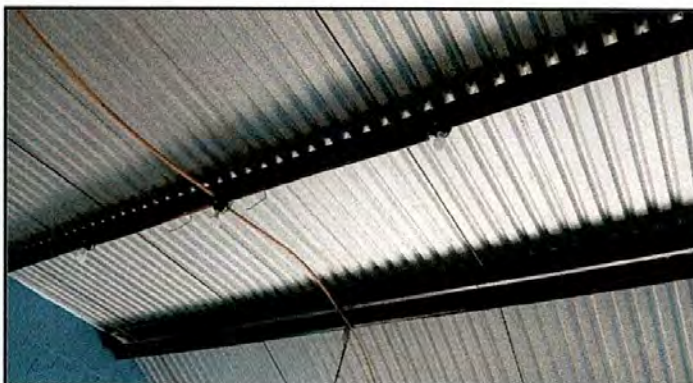
Foto 3: Aplicación de pintura en estructura de techo
