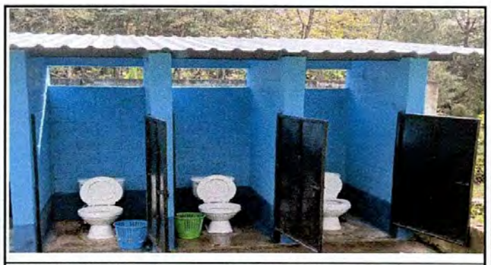
Foto 6: Sustitución de lámina y aplicación de pintura
