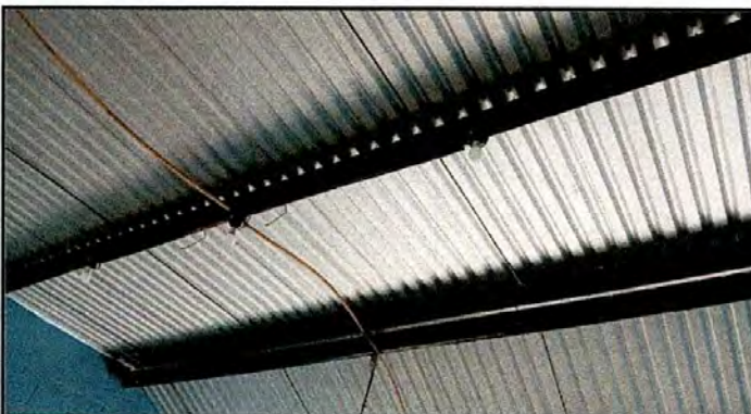
Foto 3: Aplicación de pintura en estructura de techo
