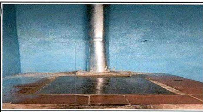
Foto 5: Instalación de plancha y chimenea de metal
