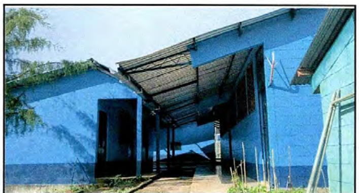
Foto 4: Aplicación de pintura
