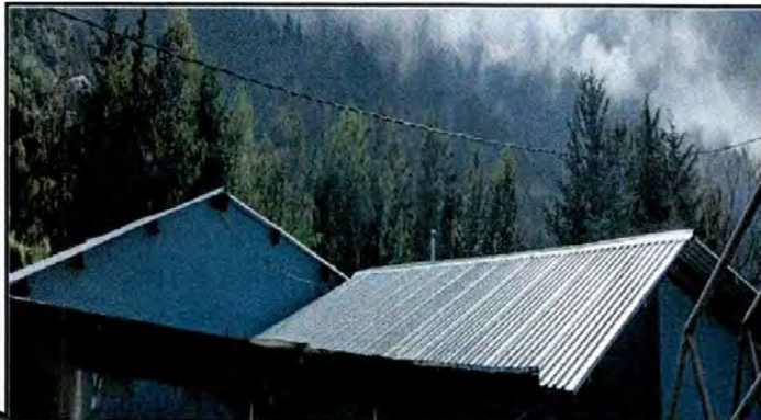
Foto1: Sustitucion de lamina por lamina toquelada
