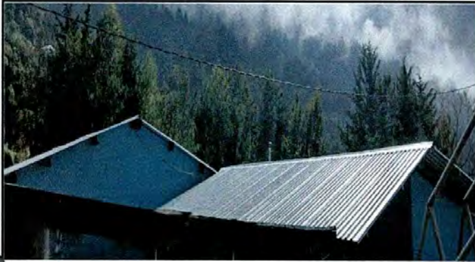
Foto1: Sustitucion de lamina por lamina toquelada
