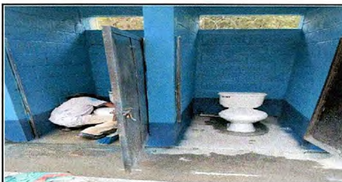
Foto 6: sustitución de inodoro
