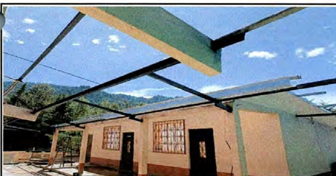
Foto 5: Instalación de capote
