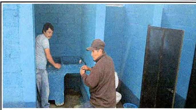
Foto 8: Instalación de pila de cemento de dos lavaderos
