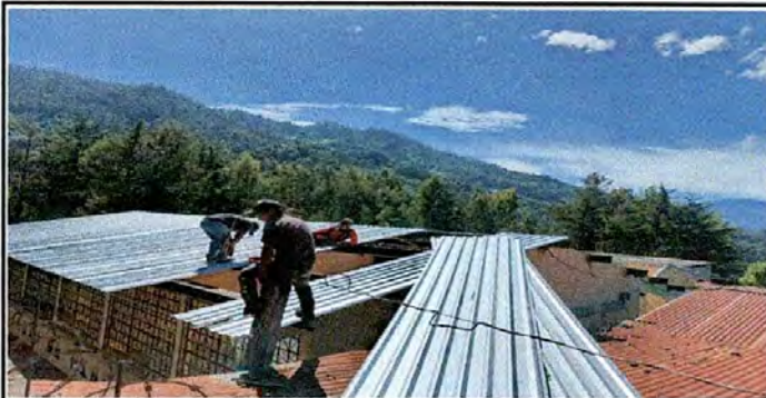
Foto1: Sustitucion de lamina por lamina toquelada
