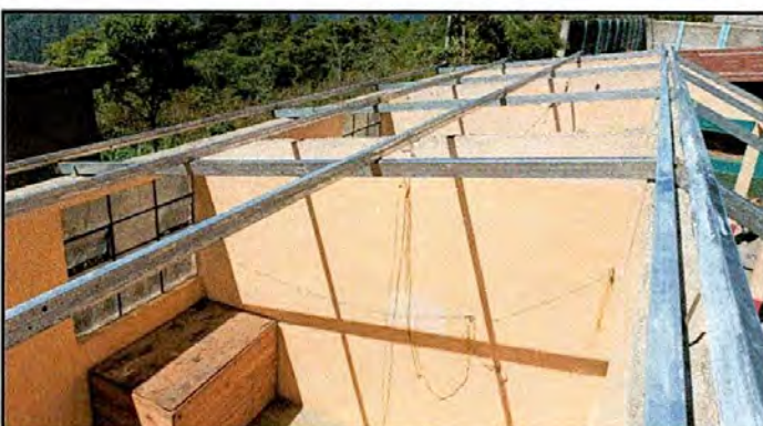
Foto 3: Sustitución de techo de madera por metal
