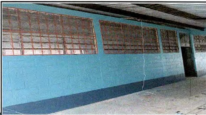
Foto7: Instalación de cableado eléctrico
