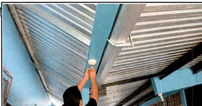
Foto 11: Instalación de focos ahorradores
