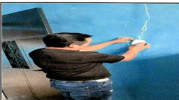
Foto 10: Instalación de tomacorrientes
