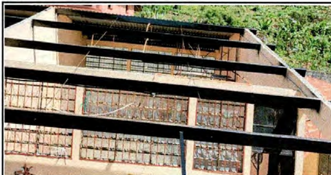
Foto 2: Matenimiento a estructura de techo
