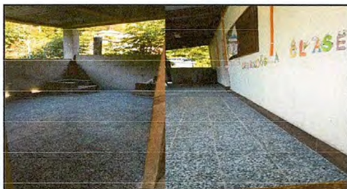
Foto 4. Instalación completa de piso de granito en area de cocina y corredor de aula 3 y 4. De la misma manera se puede observar la restauracion del sócalo en el corredor del centro educativo aula 3 y 4.
