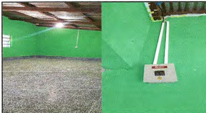
Foto 10. Se puede observar la instalación completa de plafoneras, focos ahorradores y un flipon con su caja de dos pastillas
