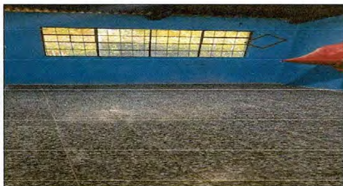
Foto 3. Instalación completa de piso de granito en la bodega y direccion del centro educativo
