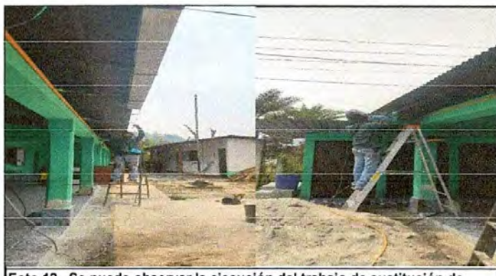
Foto 12. Se puede observar la ejecución del trabajo de sustitución de canaletas de metal para bajada de agua.
