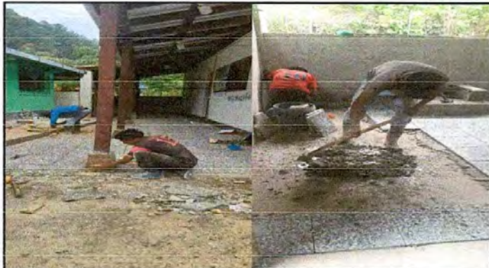
Foto 1. Se puede observar el proceso de ejecución de la sustitución de piso de concreto a piso de granito en área de cocina y corredor de aula 3 y 4. De igual manera se puede observar el remozamiento de socalo y pilares
