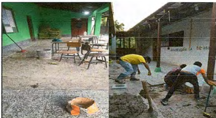
Foto 3. Se puede observar los trabajos de ejecución durante el cambio de piso de concreto a piso de granito en área de corredor de aula 1,2,3 y 4.
