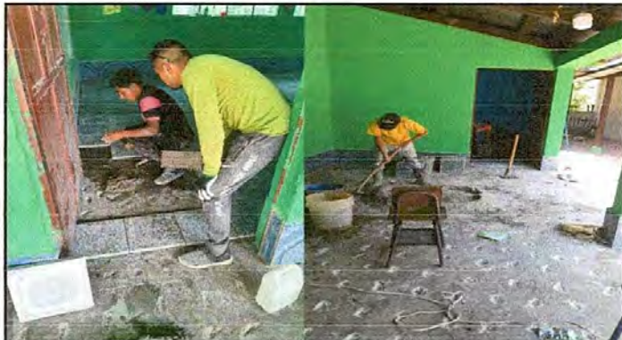
Foto 2. Se puede observar el proceso de ejecución de la sustitución de piso de concreto a piso de granito en el área de Aula 1 y 2. De la misma manera en el área del corredor
