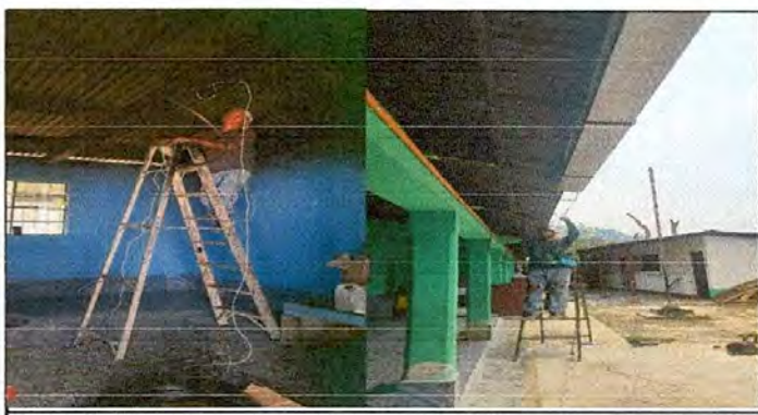
Foto 6. Se puede observar la ejecución en los trabajos de sustitución de instalaciones eléctricas y sustitución de canaletas de metal para baja de agua en el centro educativo
