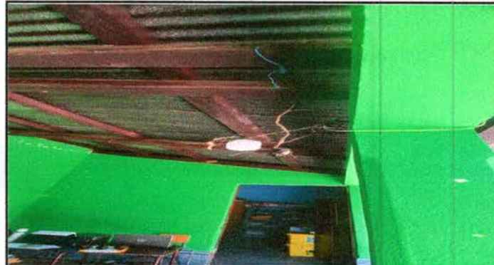
Foto 7. Sustitución de cableado eléctrico en el corredor del centro educativo.
