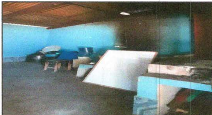
Foto 4. Mejoramiento de piso de concreto a piso de granito en bodega, sustitución de cable eléctrico en bodega
