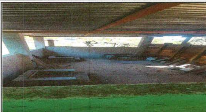
Foto 1. Mejoramiento de piso de concreto a piso de granito, sustitución de cableado eléctrico
