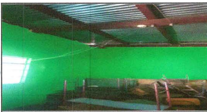
Foto 5. Mejoramiento de piso de concreto a piso de granito, sustitución de cableado eléctrico en área aula 1 del centro educativo
