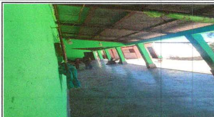
Foto 2. Mejoramiento de piso de concreto a piso de granito, sustitución de cableado eléctrico en área aula 1 y 2; bodega y dirección del centro educativo
