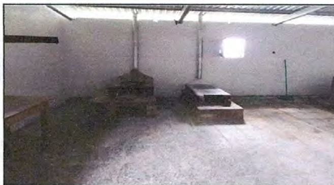
Foto 3: Sustitución de plancha de metal de 3 hornillas.
