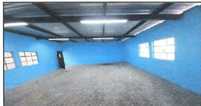
Foto 12: Pintura en muros exteriores e interiores.
