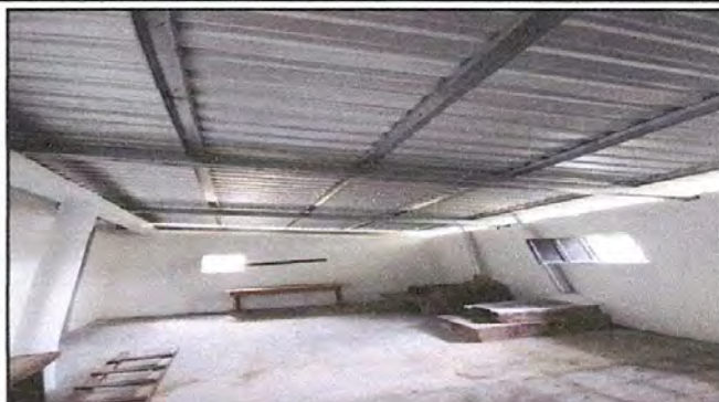
Foto 2: Sustitución estructura de madera por costanera galvanizada
