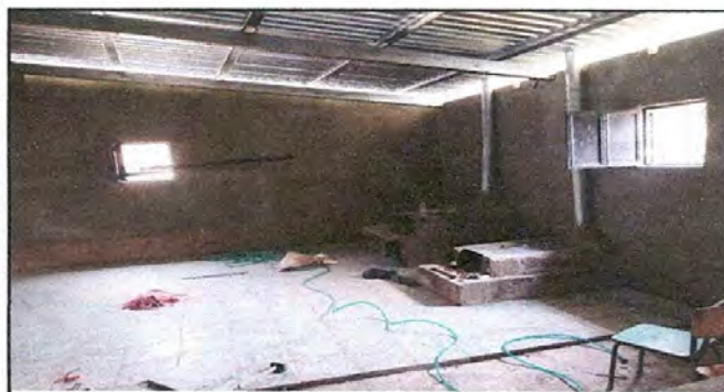
Foto 5: Sustitución de repello de cocina.
