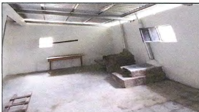
Foto 4: Sustitución de chimeneas de metal.
