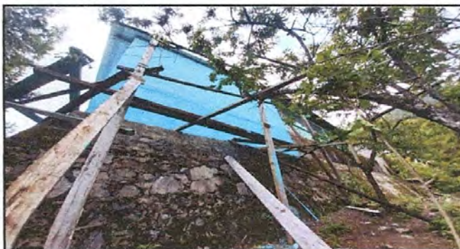
Foto 11: Pintura en muros exteriores e interiores.
