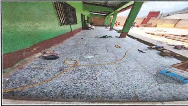
Foto 9: Sustitución de piso de concreto por piso de granito.
