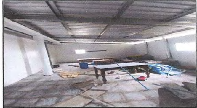
Foto 10: Pintura en muros exteriores e interiores.
