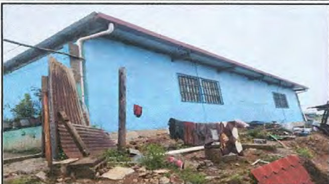
Foto 13: Pintura en muros exteriores e interiores.
