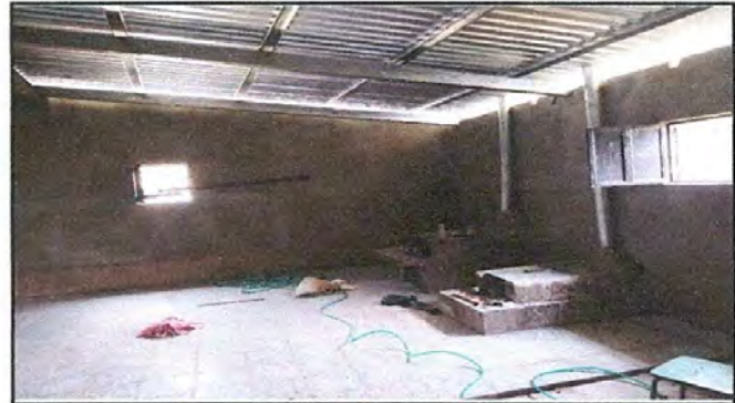
Foto 4: Sustitucion de chimeneas de metal.
