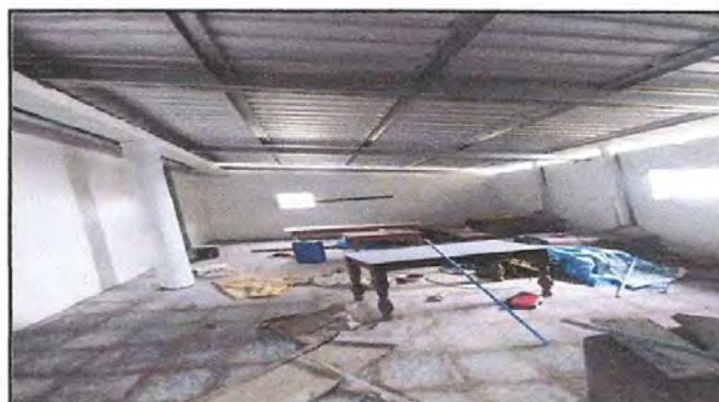
Foto 10: Pintura en muros exteriores e interiores.
