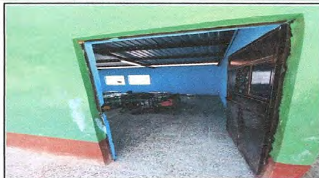
Foto 8: Sustitución de piso de concreto por piso de granito.
