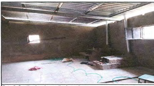
Foto 5: Sustitucion de repello de cocina.
