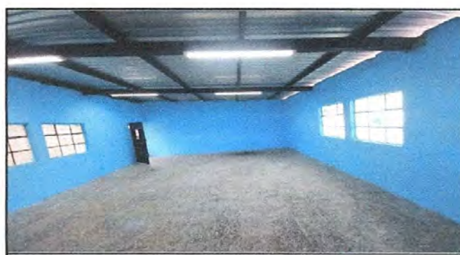
Foto 12: Pintura en muros exteriores e interiores.
