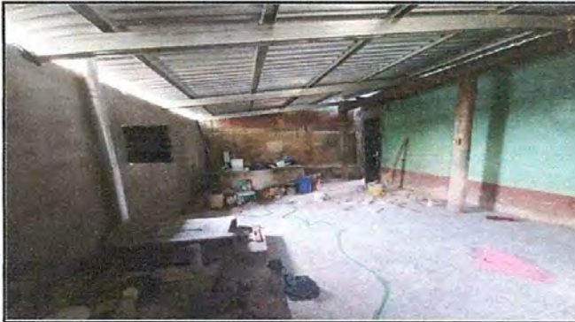
Foto 3: Sustitucion de plancha de metal de 3 hornillas.
