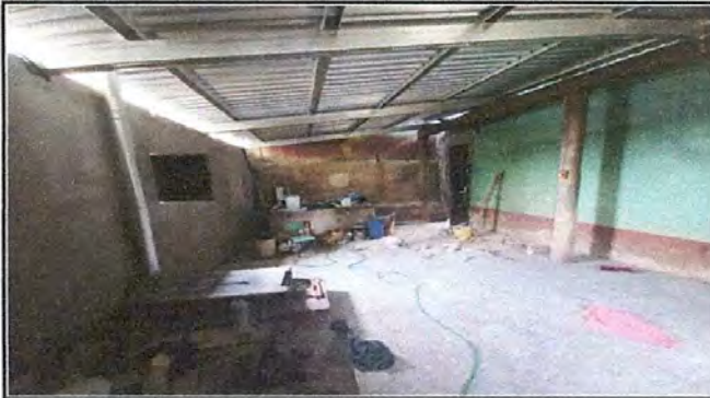
Foto1: Sustitución de lámina, por lámina troquelada Ternium Zintroalum calibre 26.
