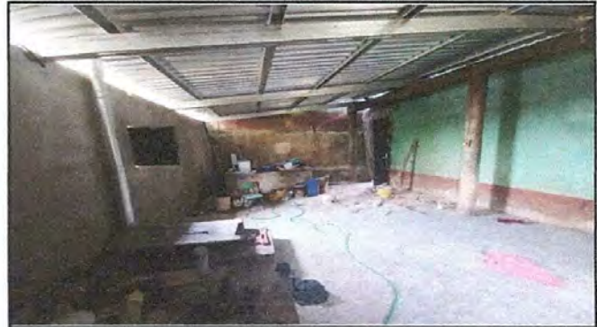
Foto 2: Sustitucion estructura de madera por costanera galvanizada
