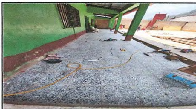
Foto 9: Sustitución de piso de concreto por piso de granito.
