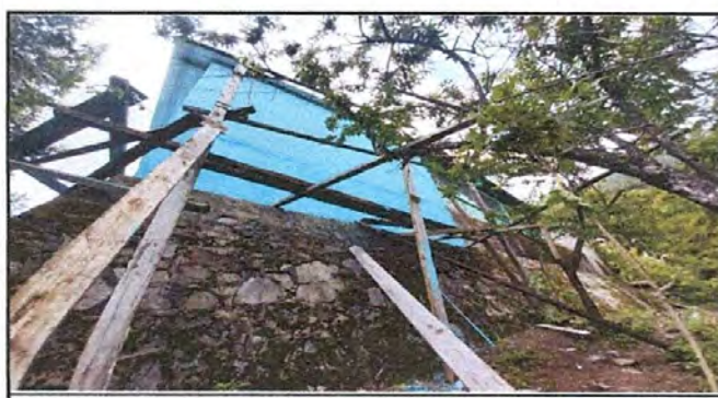
Foto 11: Pintura en muros exteriores e interiores.
