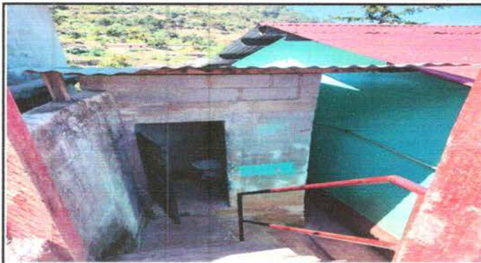
Foto 1: Sustitución de lámina troquelada aluzin calibre 26 de techo de baño.
