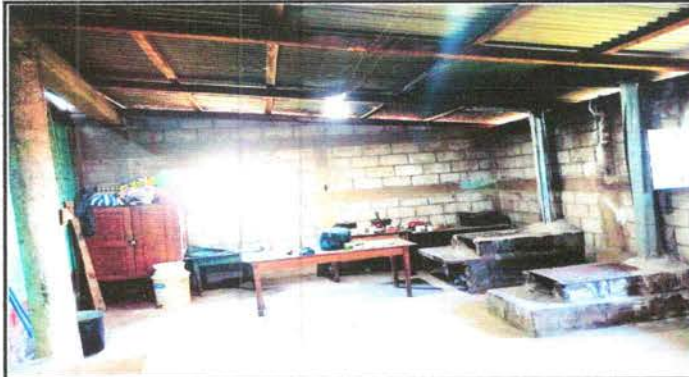
Foto1: Sustitución de lámina troquelada aluzin calibre 26.
