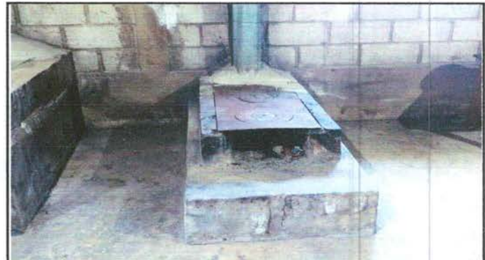
Foto 4: Sustitución de plancha de metal de tres hornillas.
