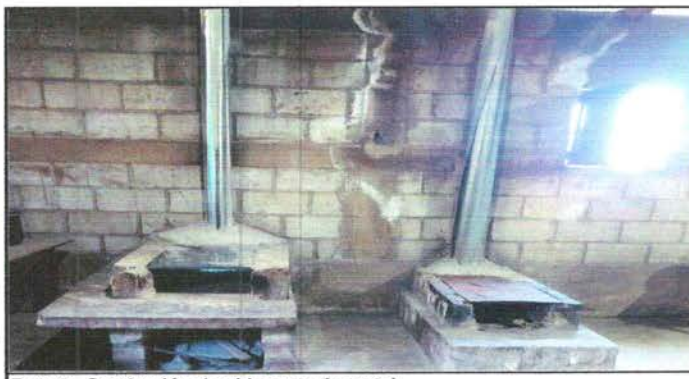
Foto 5: Sustitución de chimenea de metal.
