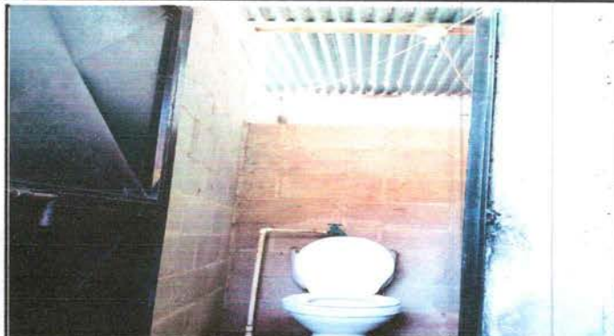
Foto 2: Sustitución de estructura de madera costanera de baño 4*2.
