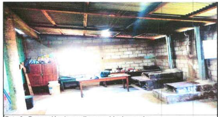
Foto 6: Reparación de repello y cernido de paredes.
