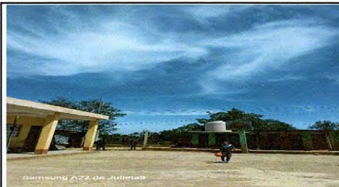
Foto 2: 2.1 Sustitución de piso de torta de concreto
