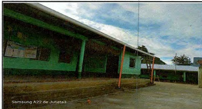
Foto 1: 1.1 Sustitución de lamina por lamina troquelada
