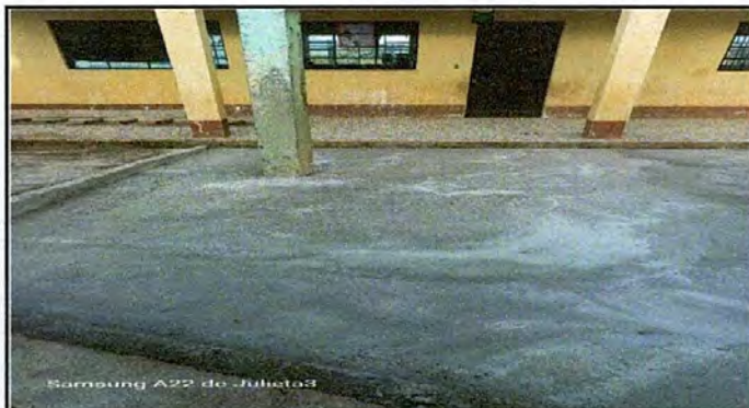
Foto 4: 2.1 Sustitución de piso de torta de concreto
