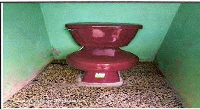
Foto 6: 4.1 Sustitución de inodoros
