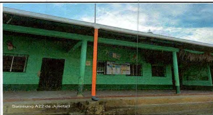
Foto 5: 3.1 y 3.2 Sustitución de canal y bajada de agua pluvial por tubo PVC
