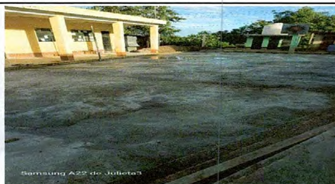
Foto 3: 2.1 Sustitución de piso de torta de concreto
