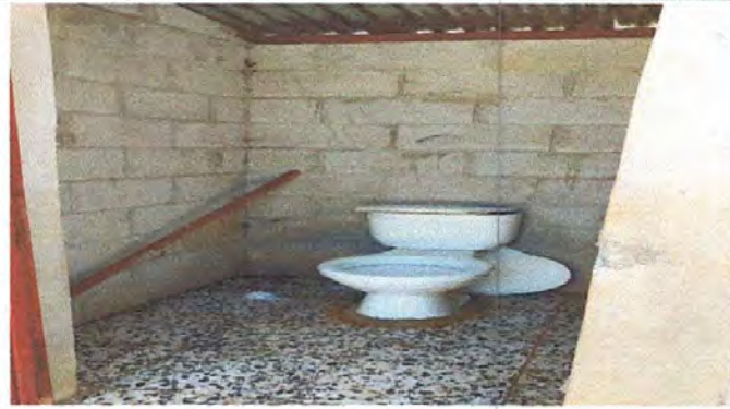
Foto 7: 4.1 Sustitución de inodoros
