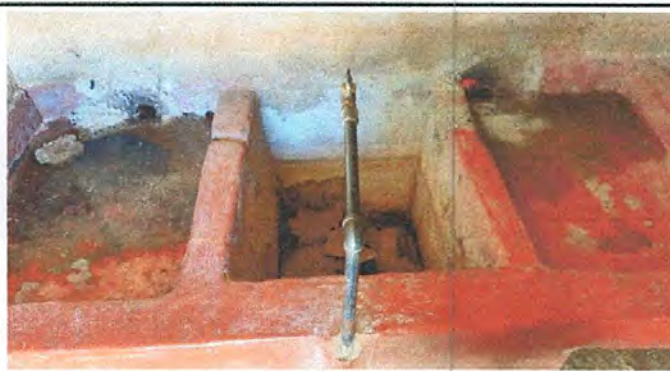
Foto 9: 5.1 Sustitución de pila de cemento de dos lavaderos
