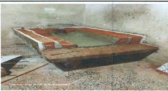
Foto 11: 5.2 Sustitución de plancha de metal
