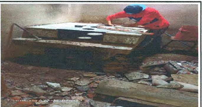
Foto 12: 5.2 Sustitución de plancha de metal
