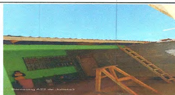
Foto 5: 3.2 Sustrucción de bajada de agua pluvial por tubo PVC
