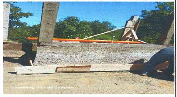
Foto 8: 5.1 Sustitución de pila de cemento de dos lavaderos
