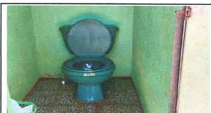
Foto 6: 4.1 Sustrucción de inodoros
