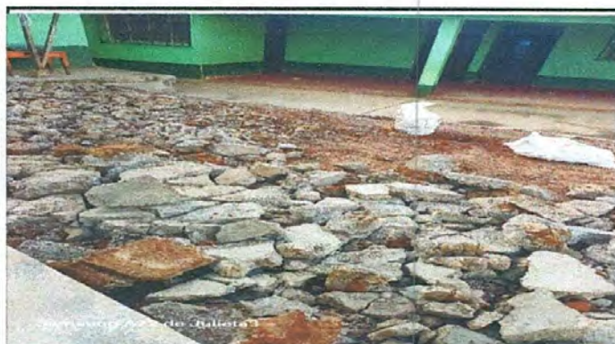
Foto 3: 2.1 Sustrucción de piso de torta de concreto
