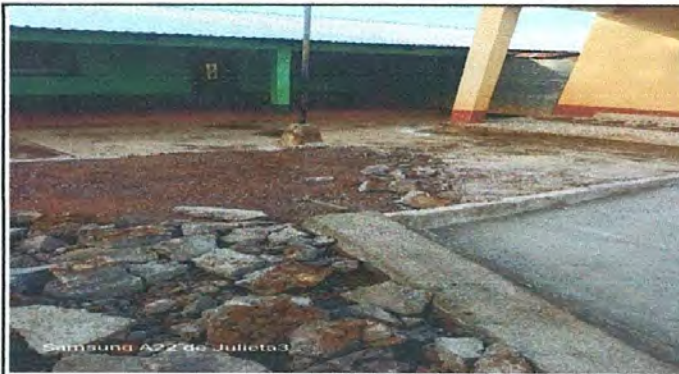
Foto 2: 2.1 Sustrucción de piso de torta de concreto
