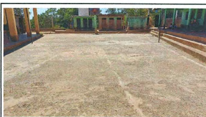
Foto 4: 2.1 Sustrucción de piso de torta de concreto
