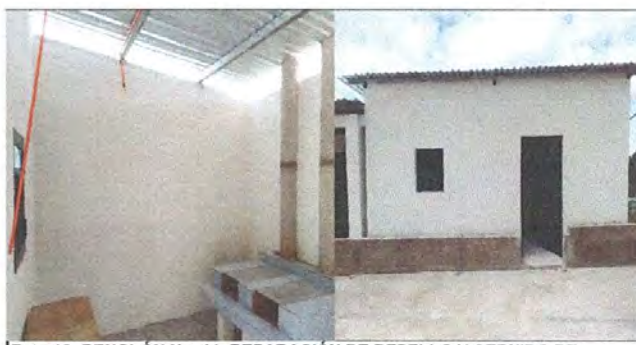
Foto 12: RENGLOÑ No. 11. REPARACIÓN DE REPELLO Y CERNIDO DE PAREDES, Mejoramiento repello en pared (Repello de interior y exterior de la cocina)
