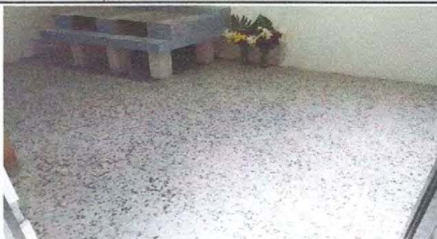
Foto 8: RENGLOÑ No. 6. PISO, Sustitución de piso de granito (Piso de la cocina)
