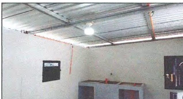
Foto 10: RENGLOÑ No. 8. REPARACIÓN DE SISTEMA ELÉCTRICO, Sustitución de Focos ahorradores, plafoneras, interruptores y tomacorrientes (Sistema eléctrico de la cocina)
