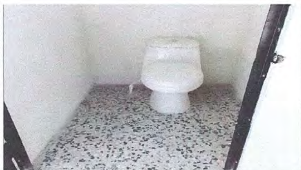
Foto 9: RENGLOÑ No. 7. SERVICIO SANITARIO Y SUS ACCESORIOS, Sustitución inodoro (Inodoros de los baños)
