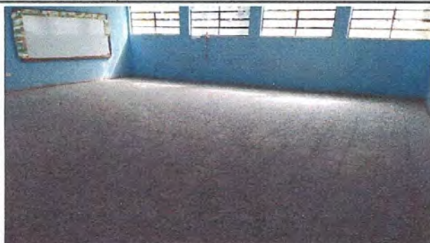
Foto 7: RENGLOÑ No. 6. PISO, Sustitución de piso de granito (Pisos de las aulas)
