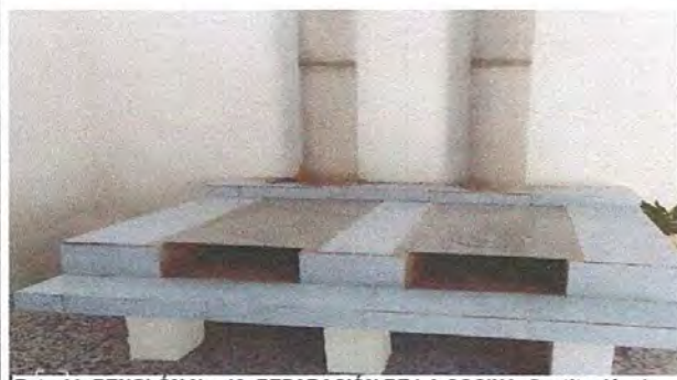
Foto 11: RENGLOÑ No. 10. REPARACIÓN DE LA COCINA, Sustitución de estufa rural (completa) incluye chimenea y plancha de metal (Estufa rural de la cocina)
