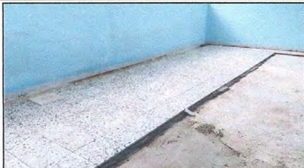
Foto 7: Renglón No. 6. PISO, Sustitución de piso de granito (Pisos de las aulas)
