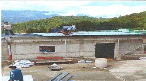
Foto 1: RENGÓN No. 1. CUBIERTA DE LÁMINA, Sustitución de lámina, por lámina troquelada aluzinc calibre 26. (Techo de la cocina)
