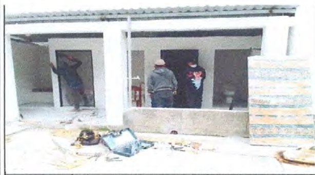
Foto 5: RENGÓN No. 3. PUERTAS DE METAL, Sustitución de puerta en servicio sanitario (Puertas de los baños)
