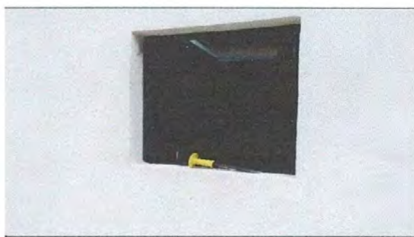
Foto 6: RENGÓN No. 5. VENTANAS, Sustitución de ventanas de madera por metal más vidrio (Ventanas de la cocina)
