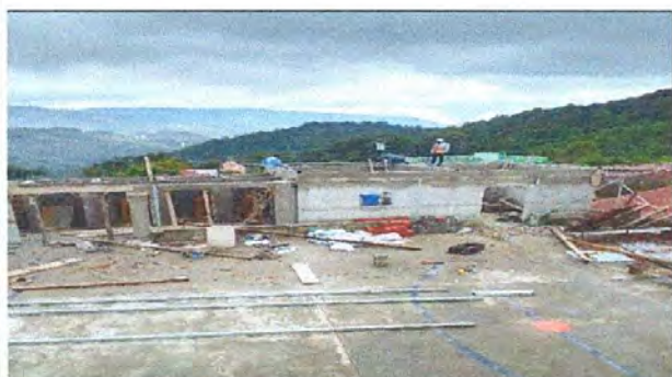
Foto 3: RENGÓN No. 2. ESTRUCTURA DE TECHO, Sustitución de estructura de soporte de madera, por metal (Estructura de soporte del techo de la cocina)
