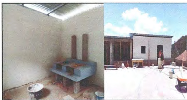
Foto 12: Renglón No. 11. REPARACIÓN DE REPELLO Y CERNIDO DE PAREDES, Mejoramiento repello en pared (Repello de interior y exterior de la cocina)
