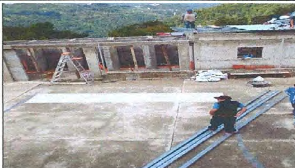
Foto 2: RENGÓN No. 1. CUBIERTA DE LÁMINA, Sustitución de lámina, por lámina troquelada aluzinc calibre 26. (Techos de los baños)
