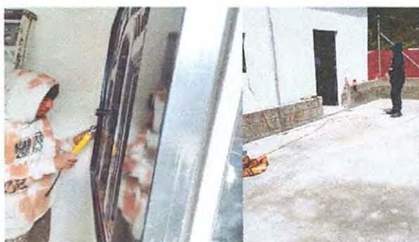
Foto 4: RENGÓN No. 3. PUERTAS DE METAL, Sustitución de puerta (Puerta de la cocina)
