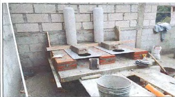
Foto 11: Renglón No. 10. REPARACIÓN DE LA COCINA, Sustitución de estufa rural (completa) incluye chimenea y plancha de metal (Estufa rural de la cocina)
