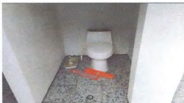
Foto 9: Renglón No. 7. SERVICIO SANITARIO Y SUS ACCESORIOS, Sustitución inodoro (Inodoros de los baños)
