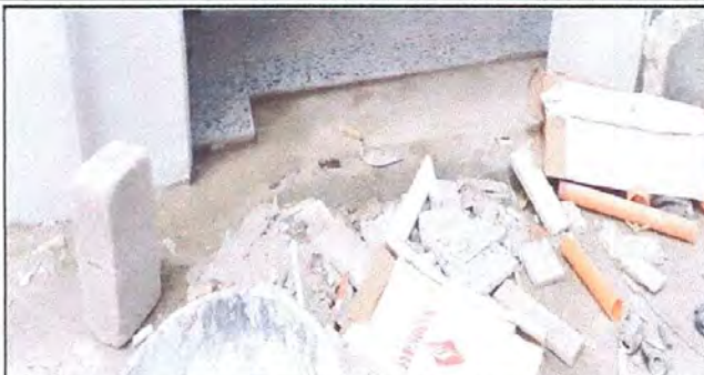
Foto 8: Renglón No. 6. PISO, Sustitución de piso de granito (Piso de la cocina)
