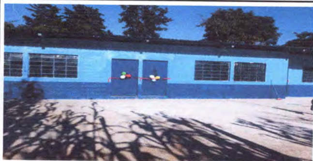
Foto1: Aulas pintadas exterior e interior
