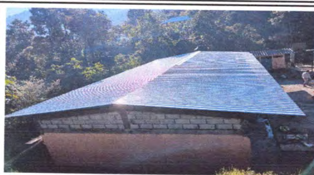
Foto 2: Muro para colocacion de techo terminado
