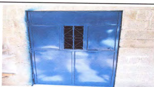
Foto 4: puerta nueva instalado .
