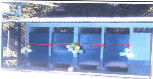
Foto 3: Puertas de baños reparadas, pintadas y colocadas
