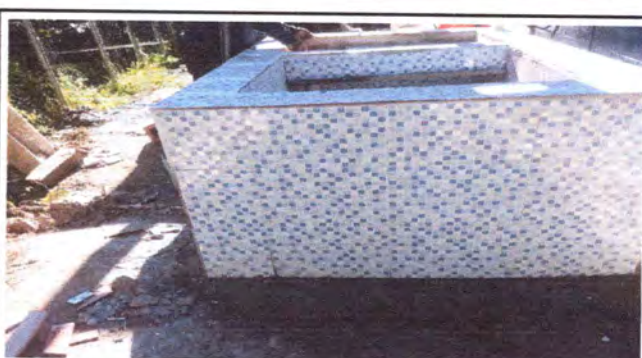
Foto 4: azulejo ya puesto con la pila
