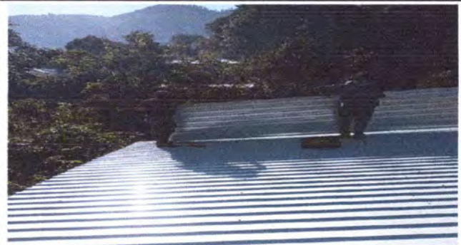
Foto 2: Mano de obra colocacion de techo
