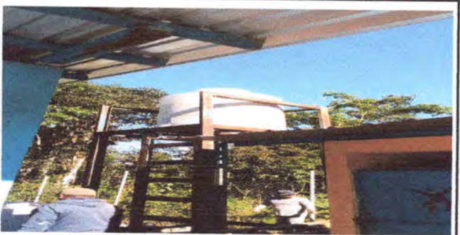
Foto 5: Sisterna instalado y trabajo culminado
