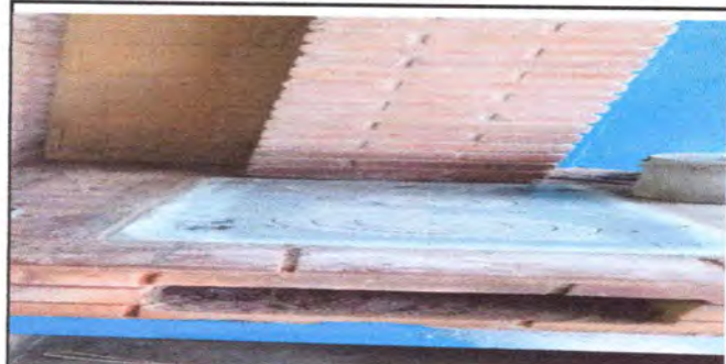
Foto 6: Plancha nueva instalada
