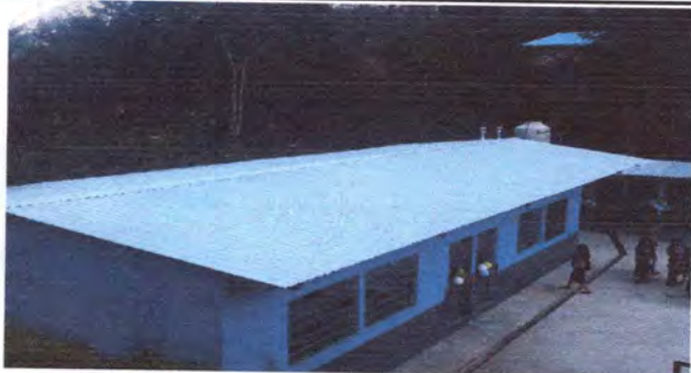
Foto1: techo de aulas ya colocado con laminas nuevas.
