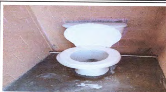
Foto 2: Inodoros instaladas en los baños
