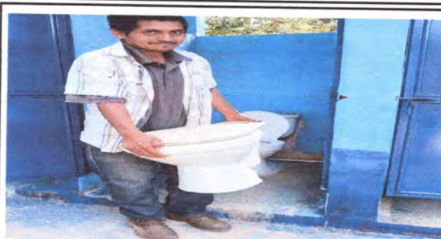
Foto 2: Cambio de tazas en los baños
