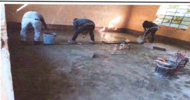
Foto 6: fundicion de piso en las aulas
