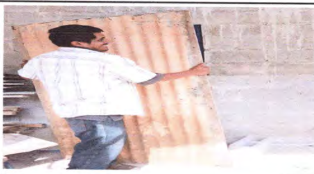
Foto 4: cambio de una puerta de metal
