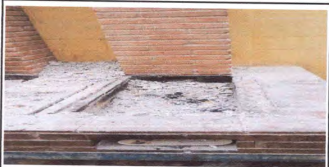
Foto 6: cambio de plancha
