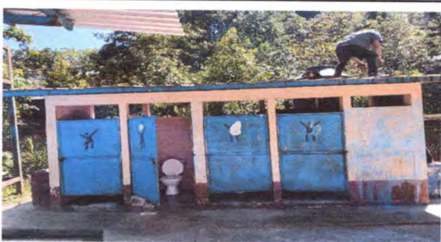
Foto 3: mantenimiento de 4 puertas de baños
