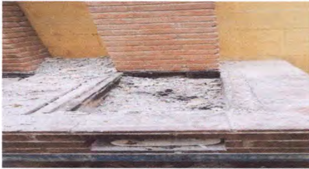
Foto1: cambio de plancha
