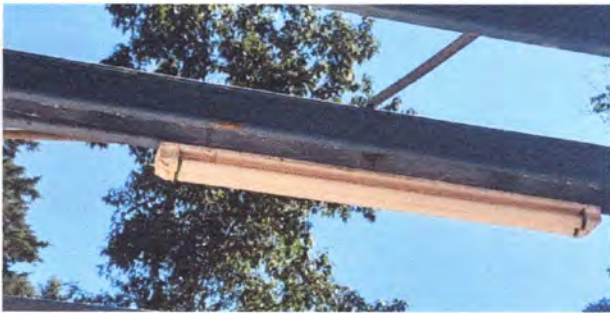
Foto 3: cambio de focos
