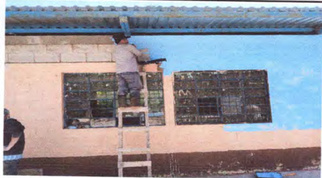
Foto1: Aplicación de pintura en las aulas
