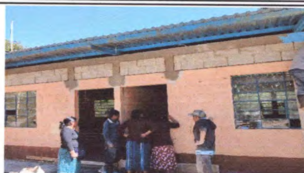
Foto 2: levantado de muro para colocacion de techos
