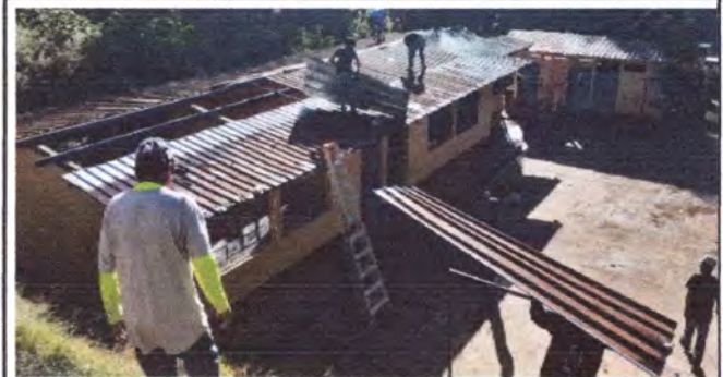
Foto 2: mano de obra con el desentechado
