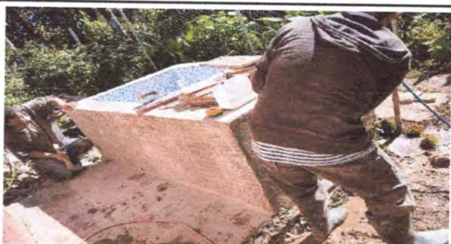
Foto 4: Colocacion de azulejos en la pila
