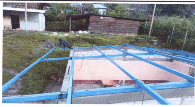
Foto1: colocacion de costaneras para el techo
