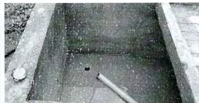
Foto 4: mantenimiento de una pila
