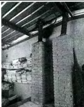
Foto 5: Tubo de Zinc de chimenea en malas condiciones
