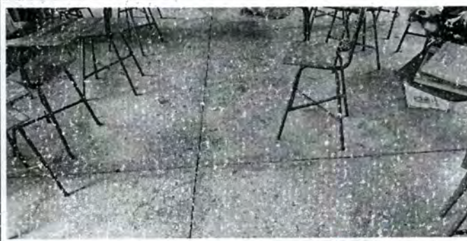
Foto 6: sustitucion piso, se encuentra en mal estado
