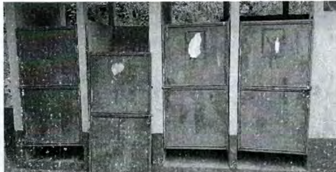
Foto 2: mantenimiento de 4 puertas para baños
