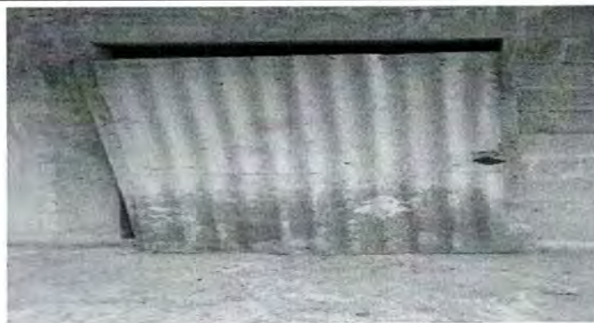
Foto 3: sustitución de puerta
