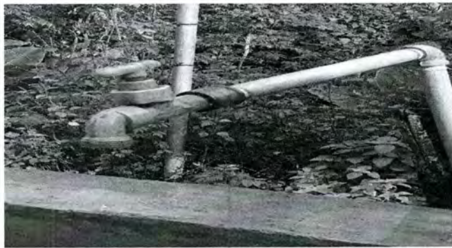
Foto1: sustitución de llave
