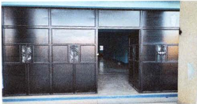
Foto 13: Mantenimiento a porton de metal, cepillado, lijado y aplicación de pintura.
