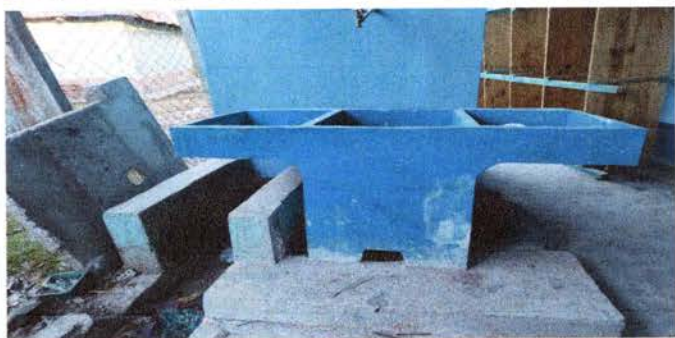
Foto 17: Sustitución de pila plástica de dos lavaderos, por pila de cemento de dos lavaderos
