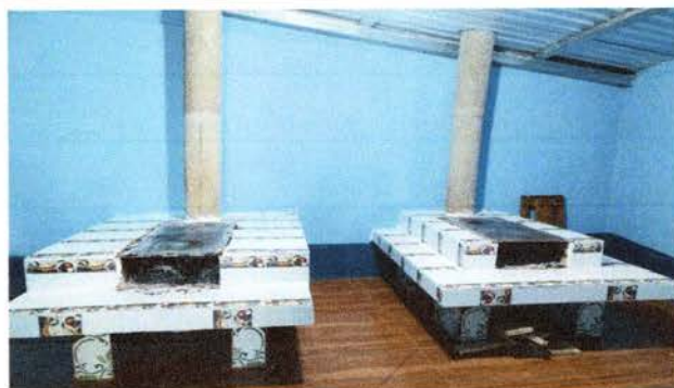
Foto 16: Sustitución de plancha
