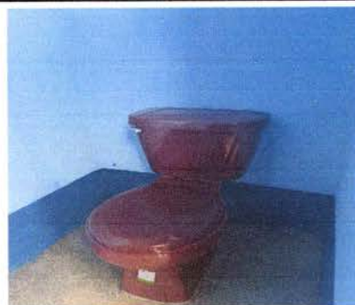
Foto 12: Sustrucción de inodoro.
