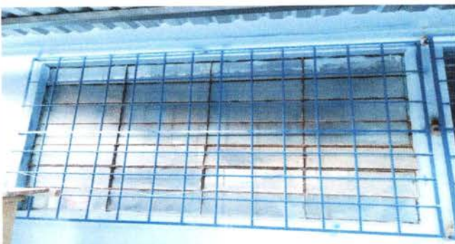
Foto 5: Mantenimiento a balcon de metal, cepillado y aplicación de pintura
