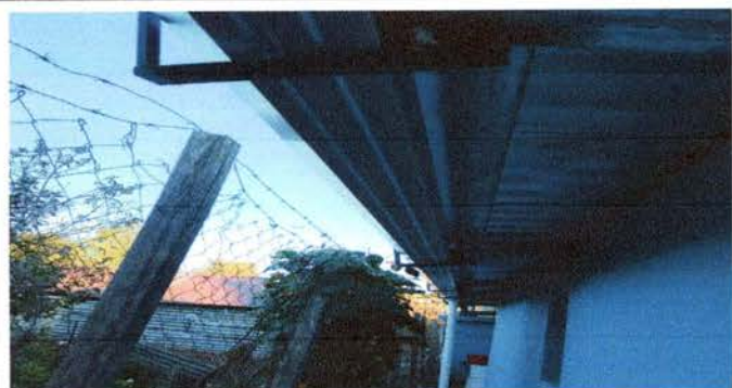
Foto 7: Sustrucción de tubo PVC, por canal de metal.
