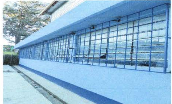
Foto 4: Sustrucción de balcones de madera por metal
