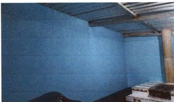
Foto 15: Mejoramiento de paredes (cocina)
