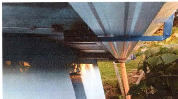
Foto 9: Mejoramiento de soporte de metal o pescante de metal para canal.
