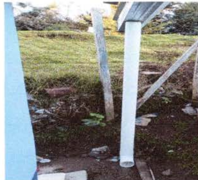
Foto 8: Sustrucción de bajada de agua pluvial PVC 3 pulg.
