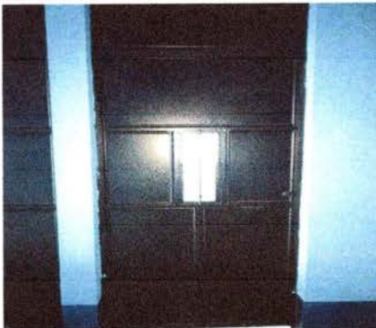
Foto 3: Mantenimiento a estructura de puertas en aulas cepillado, lijado y aplicación de pintura
