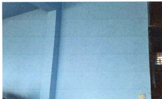
Foto 10: Aplicación de pintura en muros exteriores e interiores.
