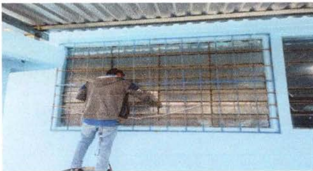
Foto 5: Mantenimiento a balcón de metal, cepillado y aplicación de pintura
