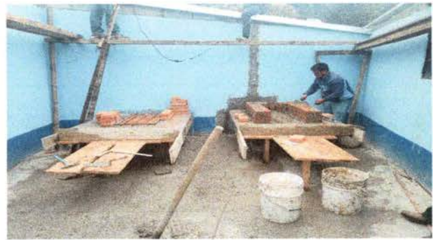
Foto 16: Sustitución de plancha
