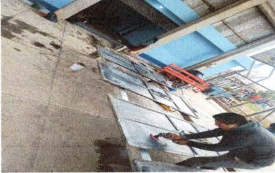
Foto 13: Mantenimiento a porton de metal, cepillado, lijado y aplicación de pintura.
