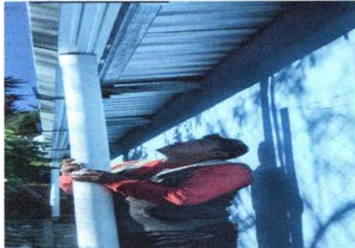
Foto 8: Sustitución de bajada de agua pluvial PVC 3 pulg.
