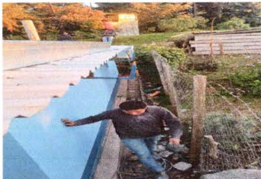
Foto 7: Sustitución de tubo PVC, por canal de metal.
