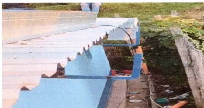
Foto 9: Mejoramiento de soporte de metal o pescante de metal para canal.
