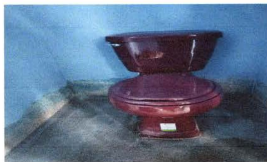
Foto 12: Sustitución de inodoro.
