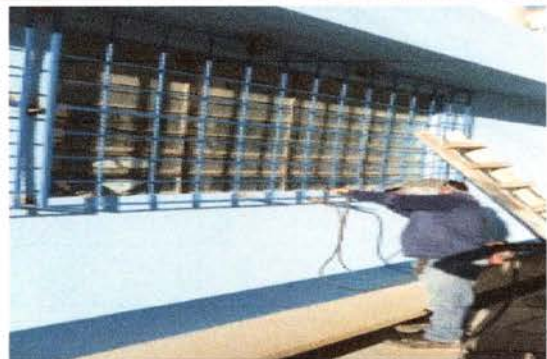
Foto 4: Sustitución de balcones de madera por metal
