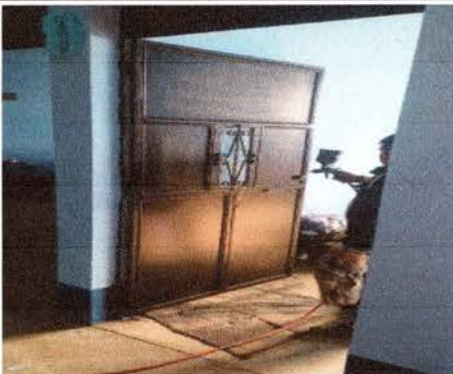
Foto 3: Mantenimiento a estructura de puertas en aulas cepillado, lijado y aplicación de pintura
