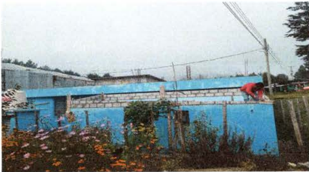
Foto 15: Mejoramiento de paredes (cocina)
