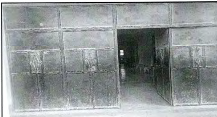
Foto 9: mantenimiento a porton de metal
