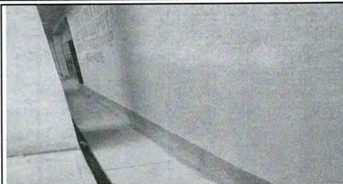
Foto 7: Pintura en muros exteriores e interiores
