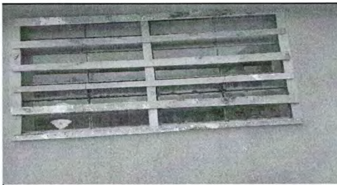
Foto 4: Sustitución de balcones de madera por metal
