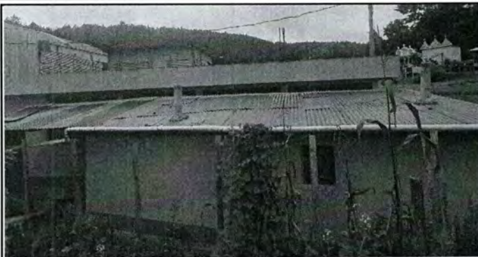
Foto 1: Sustitución de lámina por lámina troquelada aluzinc
