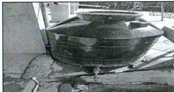
Foto 10: Sustitución de deposito de agua de 1100 lt
