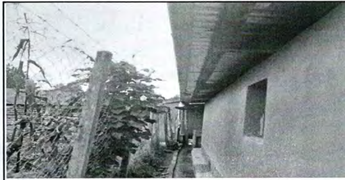
Foto 6: Sustitución de canaleta
