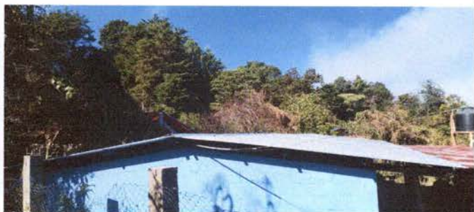
Foto 1: Instalado de lámina troquelada calibre 26
