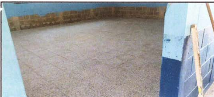
Foto 5: Sustitución de piso de torta de concreto, finalizo y así le quedó albañil
