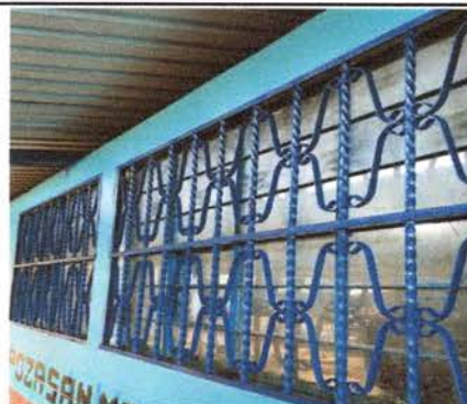
Foto 4: mantenimiento de balcones, se utilizó la pintura de acuerdo a lo establecido
