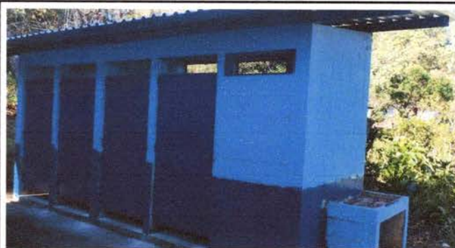
Foto 2: sustitucion de puertas de baño, fue asi como quedaron las cuatro puertas
