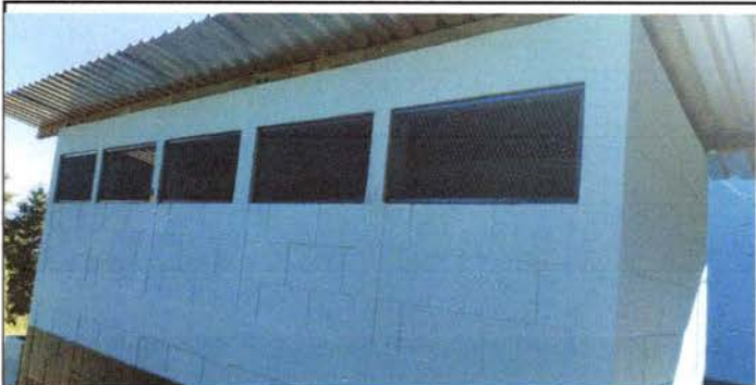
Foto 3: mejoramiento de ventanas, se puede apreciar que se sellaron los espacios
