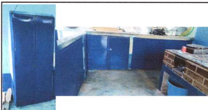
Foto 6: Sustitucion de puerta, se mejoro a como muestra la imagen
