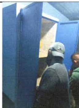
Foto 6: Sustitucion de puerta, en este region porque fue trabajado fuera del predio escolar ya solo fue la instalacion de la puesta
