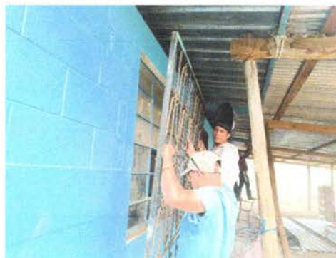
Foto 4: mantenimiento de balcones para este trabajo se tuvo que quitar los balcones
