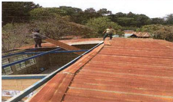
Foto1: sustitucion de cubierta de lamina, como se puede apreciar enpesaron a quitar la lamina vieja y oxidada
