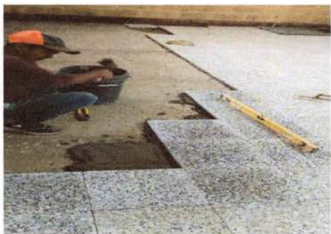
Foto 5: Sustitución de piso de torta de concreto se puede apreciar como fueron colocando el piso de granito
