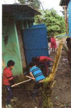
Foto 2: sustitucion de puertas de baño, en este region por que fue trabajado fuera del predio escolar ya solo la puerta de puertas, pero los niños hicieron la limpieza antes de iniciar el trabajo
