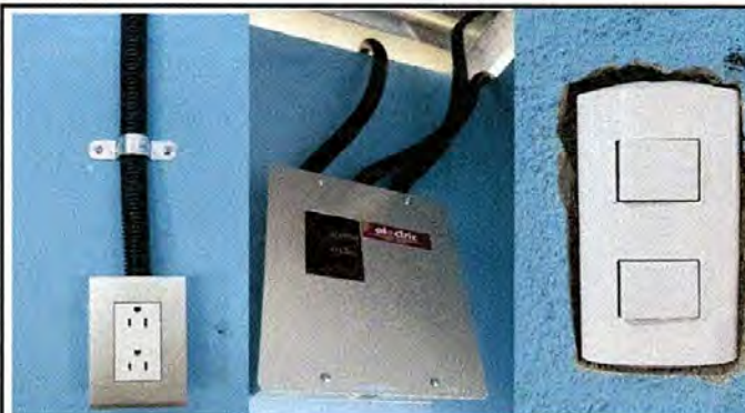
Foto 22: Evidencia fotográfica de la reparación y sustitución del ducto electrico + accesorios
