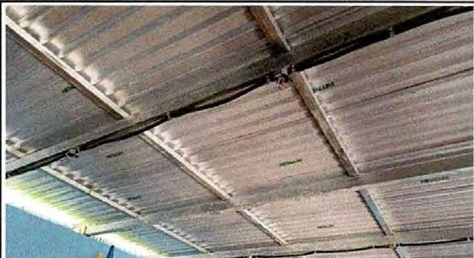
Foto 1: Evidencia Fotográfica de sustitución de cambio de techo de lámina troquelada aluzinc calibre 26 y tubos de soporte de estructura de metal
