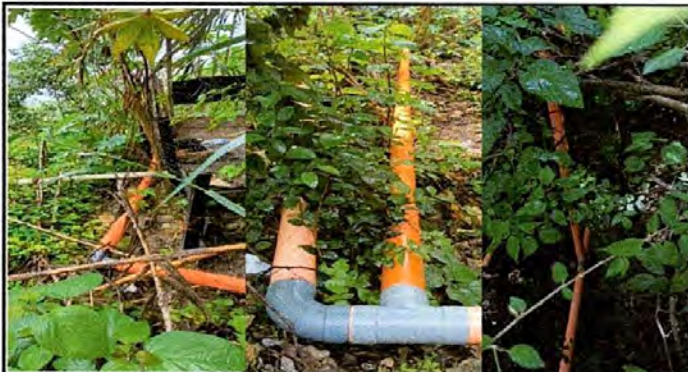
Foto 19: Reparación completa de las conexiones de la red de drenaje del centro educativo
