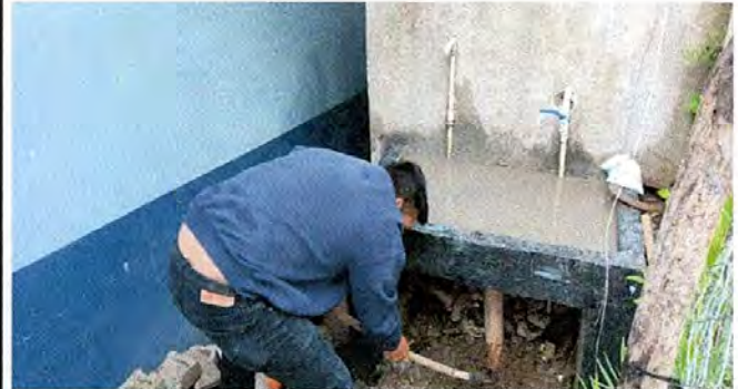
Foto 16: reparación de red de drenaje del centro educativo en proceso a remozar
