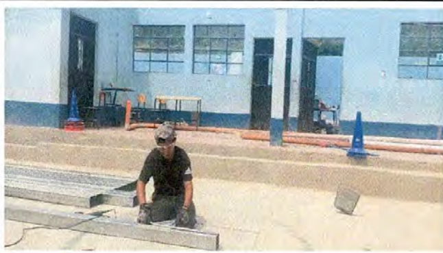
Foto 3: Evidencia fotográfica del especialista en estructuras metálicas
