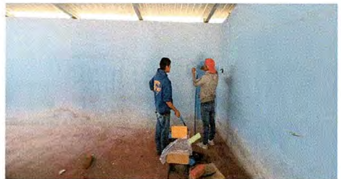
Foto 10: mantenimiento a muros interiores del centro educativo
