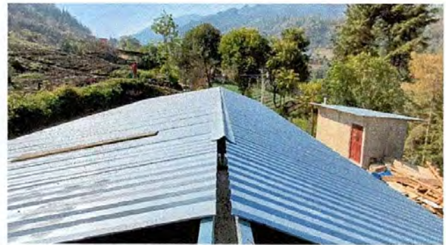
Foto 4: Sustitución de capotes de lámina troquelada en proceso de remozamiento
