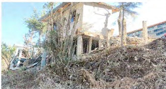
Foto 9: Muros exteriores a remozar del centro educativo
