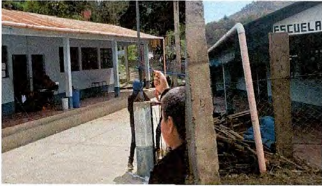
Foto 7: Sustitución de canales y bajadas de agua pluvial del centro educativo
