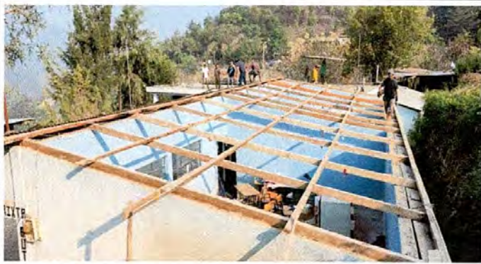
Foto 1: Sustitución de soporte de madera a remozar en el centro educativo
