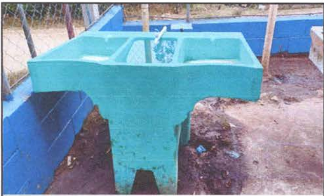
FOTO 10: Se sustituyó la pila por una nueva.
