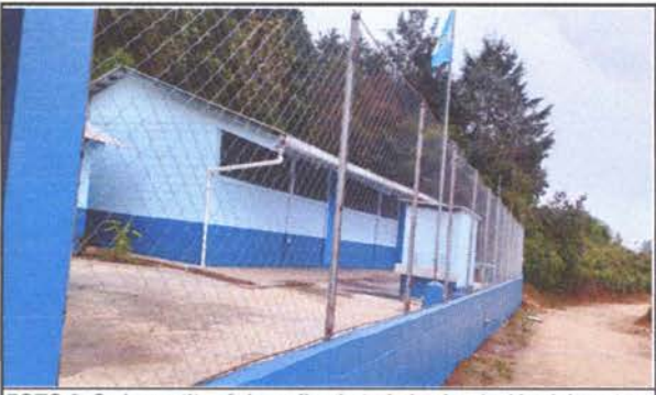
FOTO 6: Se le sustituyó la malla de toda la circulación del centro educativo, utilizando varillas de hierro, como también se le dio mantenimiento a los tubos que se encuentran en la circulación.
