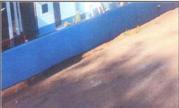
FOTO 4: Se le dio mantenimiento al muro, se lijó para quitar el musgo y la pintura que tenía anteriormente y se le aplicó pintura.
