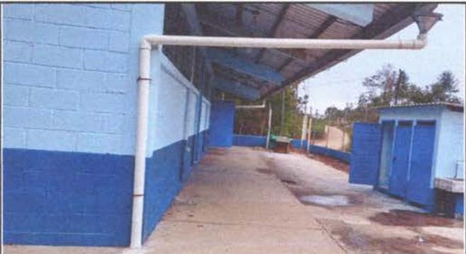
FOTO 3: Se Cambiaron los tubos de pvc de 4 canales de bajadas de agua pluvial y el cambio de los 4 conos que receptionan el agua.
