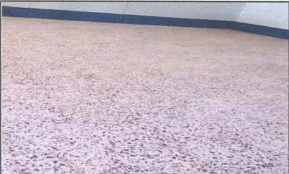
FOTO 2: Se cambió el piso de cemento líquido por 142 m2 de piso de granito, aulas, cocina, baños y dirección.
