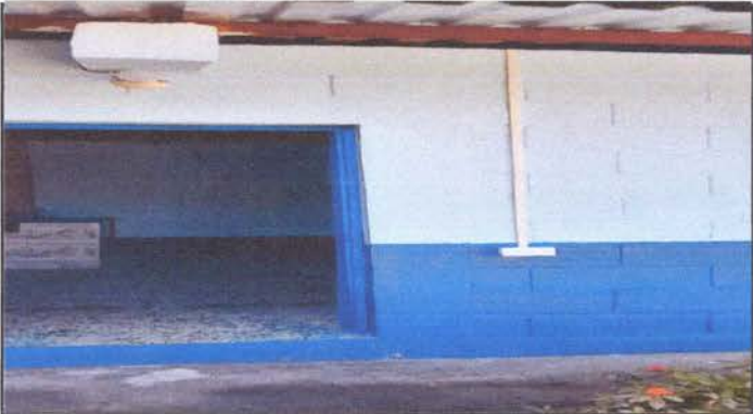
FOTO 7: Se realizó la instalación eléctrica, de manera mas adecuada para el Centro educativo, así también se hizo el acercamiento del contador al centro educativo.
