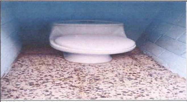
FOTO 5: Se sustituyó dos inodoros por nuevos.
