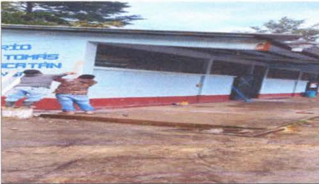
FOTO 3: Instalando el nuevo canal de agua pluvial.
