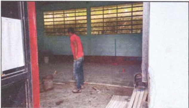
FOTO 2: Instalando el piso de granito, en el segundo aula.
