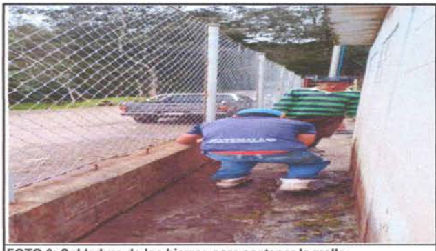
FOTO 6: Soldadura de los hierros para sostener la malla.
