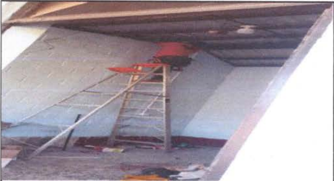
FOTO 7: Instalando el cableado eléctrico.
