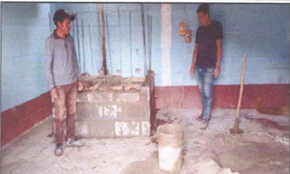
FOTO 8: Iniciando la fundición para la elaboración de la estufa rural.
