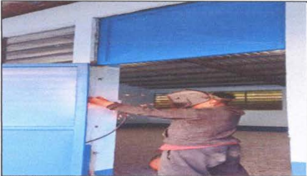
FOTO 1: Se está soldando al instalar las puertas.
