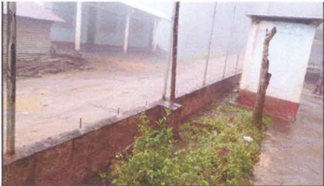
FOTO 4: Fundición de hierros que servirán para sostener la mallan
