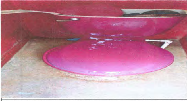
FOTO 5: Sustitución de inodoros
