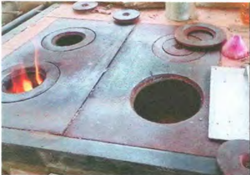
FOTO 8:La plancha está oxidada y tiene partes agrietadas
