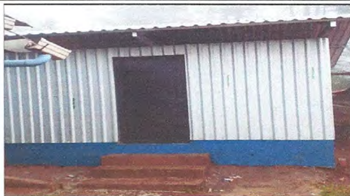
Foto 2: cocina. Finalización de la cocina donde se va a preparar los alimentos de los niños.
