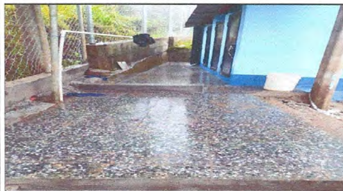
Foto 3: Baños. Acabado de colocación de pizo de granito donde se va a colocar la pila de dos lavaderos.
