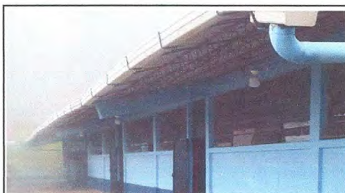
Foto 10: vidrios. Mantenimiento de vidrios quebrados y colocación de la misma.
