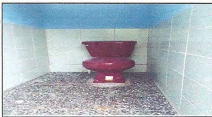
Foto 11: Taza baño. Finalización y colocación de tazas de los baños.
