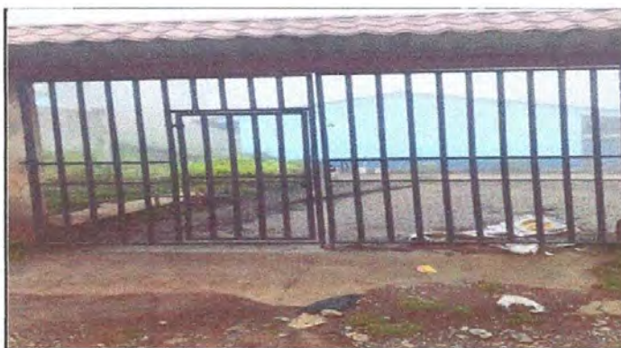
Foto 9: Portón. Pintado y colocacion de maya galvanizada del porton de entrada del centro educativo.
