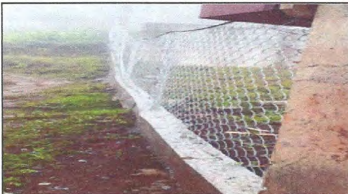
Foto 7: Muro perimetral. Terminación de la completación de concreto en el muro perimetral del area del centro educativo.
