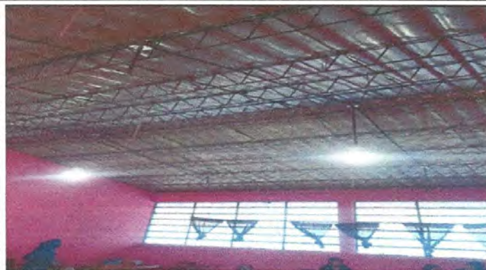
Foto1: Energía. Cambio de las lamparas dentro de todas las aulas y la dirección del establecimiento.
