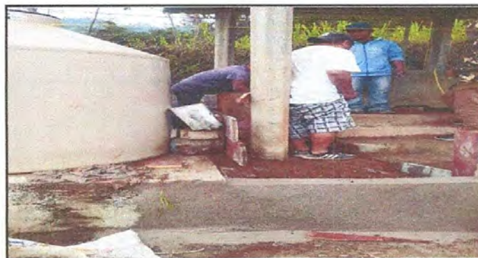
Foto 6: Pila. Colocación de pizarra de granito en el depósito de agua y cambio de pila de dos lavaderos
