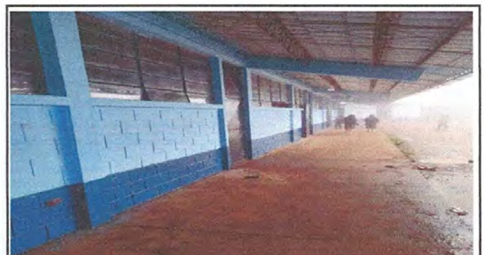
Foto 10: vidrios. Cambio de vidrio de las ventanad de las aulas.
