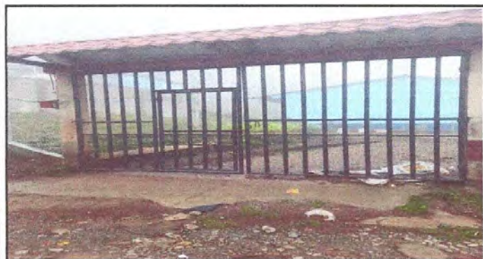
Foto 9: Portón. Pintado y colocación de maya galvanizada en el porton de metal.
