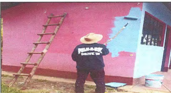
Foto 5: Escuela. Pintado de pared del exterior del centro educativo.
