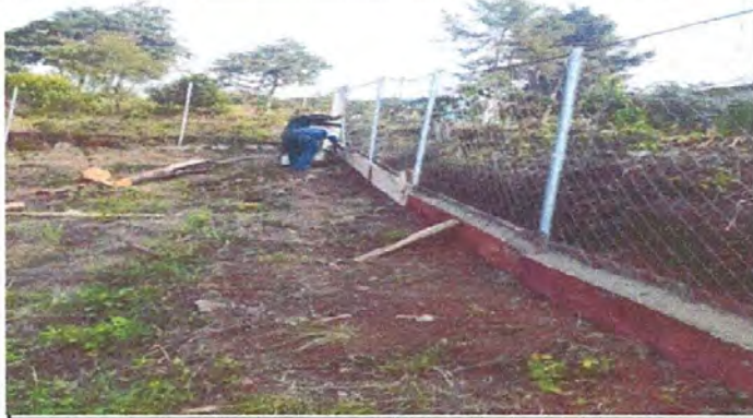
Foto 7: Muro perimetral. Mantenimiento al muro perimetral con aplicación de concreto en las partes dañadas.
