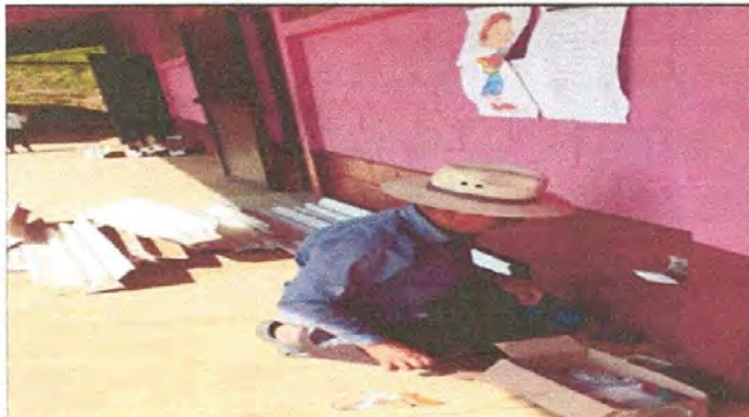
Foto1: Instalación de luz. Mantenimiento de los accesorios de energía eléctrica dentro y fuera de las aulas del centro educativo.
