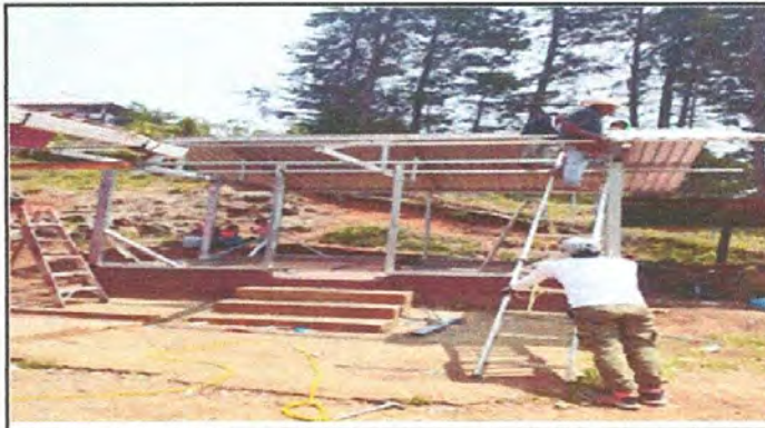
Foto 2: cocina. Colocación de lámina troquelada para el techo de la cocina.
