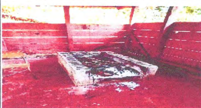
Foto No. 9. Sustitución de estufa rural (completa) incluye chimenea y plancha de metal, sustitución de madera por lamina troquelada aluzin calibre 26 y sustitución de madera por costanera.
