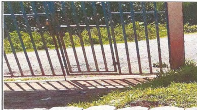
Foto 9: Portón. Mantenimiento a portones de metal pintado y colocación de maya galvanizada.
