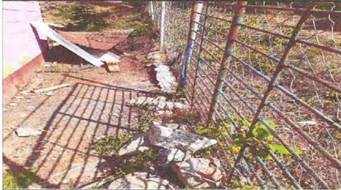
Foto 7: Muro perimetral. Mantenimiento de muro perimetral con cemento y concreto.
