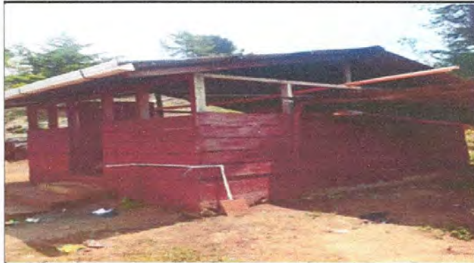
Foto 2: cocina: Sustitución de estufa rural incluyye chimenea y plancha de metal , sustitución de madera por lamina troquelada aluzin calibre 26 y sustitución de madera por costanera.
