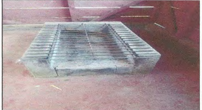
Foto 8: Estufas rurales. Sustitución de estufa rural (completa) incluye chimenea y plancha de metal.
