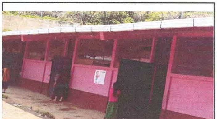
Foto 10: vidrios. Sustitución de vidrio de ventana de las aulas.
