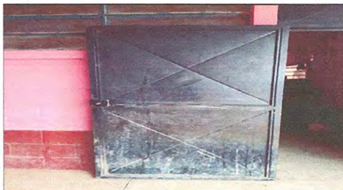
Foto 4: Puerta de las aulas. Sustitución de chapas de las aulas 1,2,3,4,5, dirección y bodega
