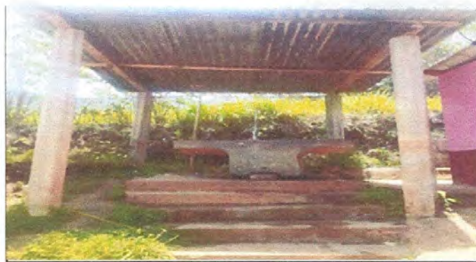
Foto 6: Pila. Sustitución de lámina troquelada aluzin calibre 26 para techo de pila y cocina, sustitución de pila de dos lavaderos
