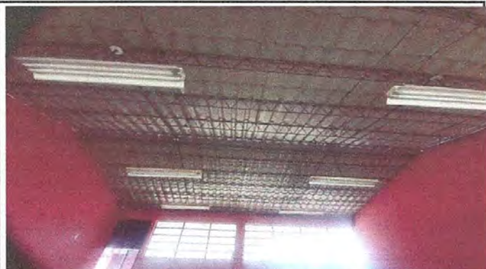
Foto1: Energía: Sustución de lamparas, plafoneras y tomacorrientes.
