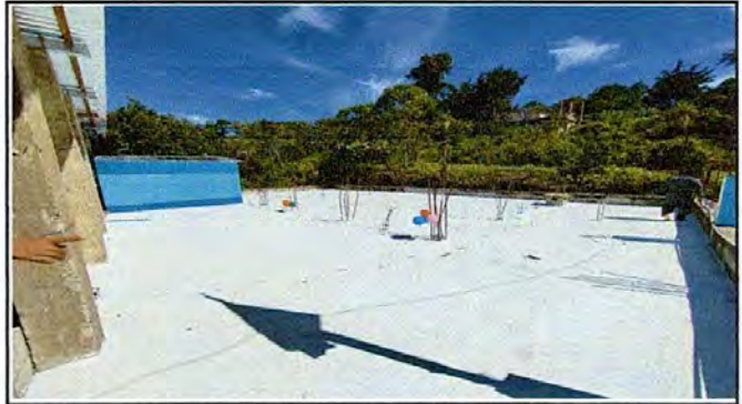
Foto 8: /Impermeabilización de losa/Fuente: Archivo Propio
