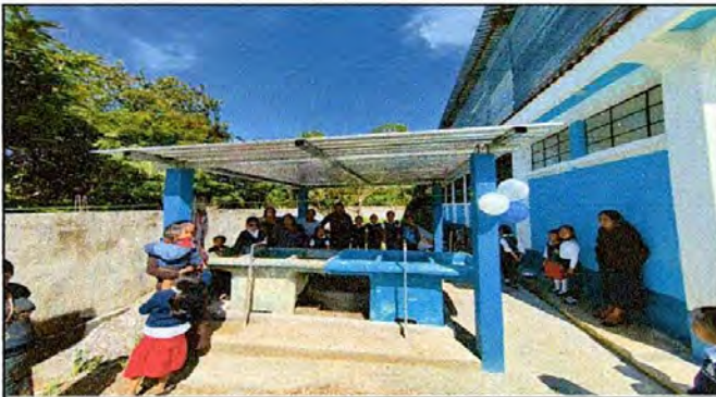
Foto 9: /Sustrucción de la pila/Fuente: Archivo Propio
