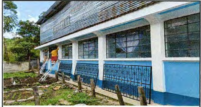
Foto 2: Fabricación e instalación de balcones para ventanas/Fuente: Archivo Propio
