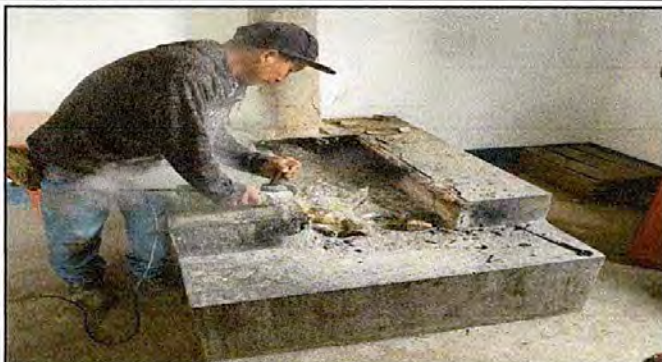
Foto 7: /Sustitución de Plancha/Fuente: Archivo Propio
