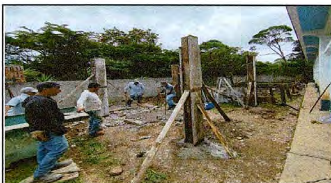
Foto 10: /Sustitución de lamina/Fuente: Archivo Propio
