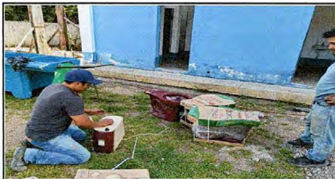
Foto 5: Sustitución de inodoros/Fuente: Archivo Propio
