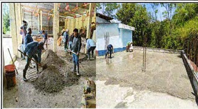
Foto 8: /Impermeabilización de losa/Fuente: Archivo Propio
