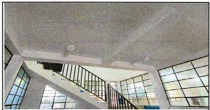
Foto 6: Sustitución de focos ahorradores/Fuente: Archivo propio
