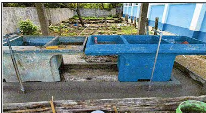
Foto 9: /Sustitución de la pila/Fuente: Archivo Propio
