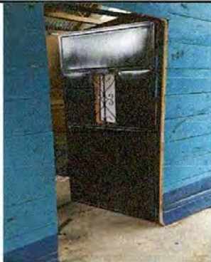
Foto 5: Sustitución de puerta de madera por metal
