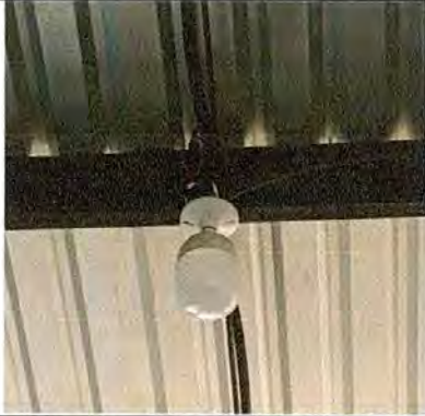
Foto 13: Sustitución de cableado y ducto eléctrico
