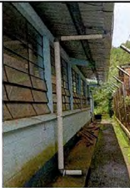
Foto 9: Sustrucción de bajada de agua pluvial de tubo por tubo PVC 3"
