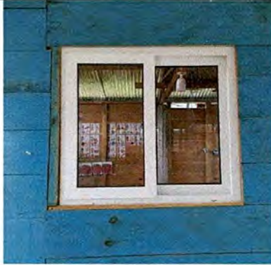
Foto 7: Sustrucción de ventana de madera por metal mas vidrio
