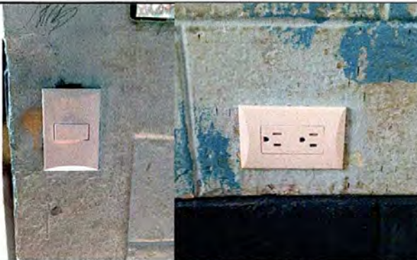
Foto 11: Sustrucción de apagadores y tomacorrientes
