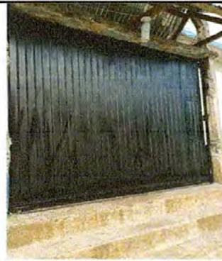
Foto 6: Sustitución de portón de metal
