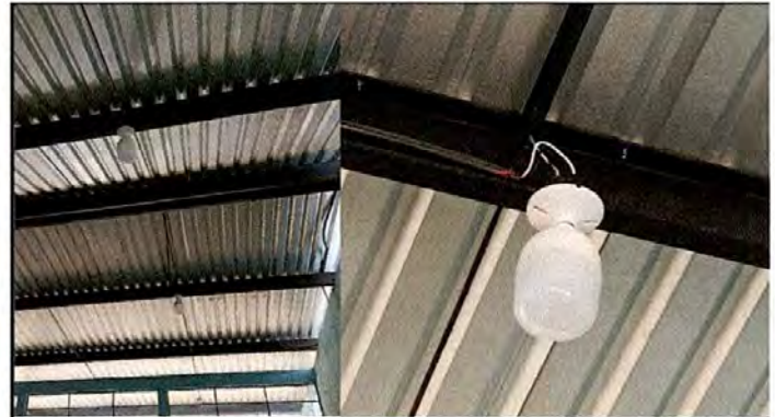
Foto 10: Sustrucción de lamparas ahorradores y flaponeras
