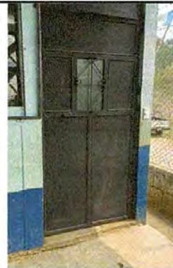
Foto 4: Mantenimiento a estructuta de metal
