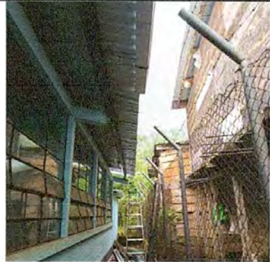
Foto 8: Sustitucion de canal de metal
