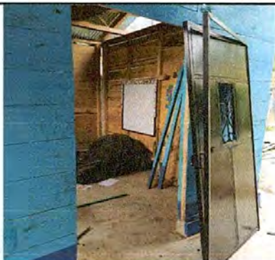
Foto 5: Sustitución de puerta de madera por metal
