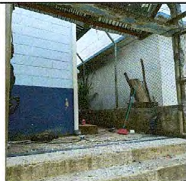
Foto 6: Sustitución de portón de metal
