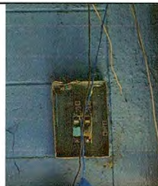
Foto 12: Sustitución de flipon
