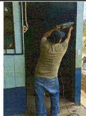
Foto 4: Mantenimiento a estructura de metal
