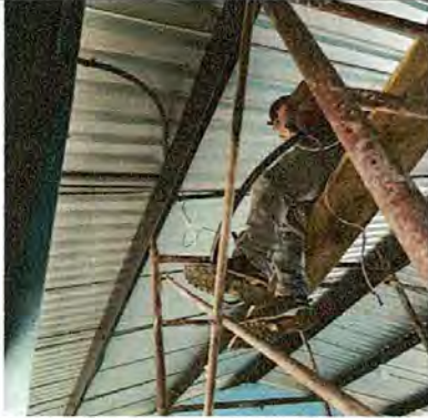
Foto 13: Sustitución de cableado y ducto eléctrico
