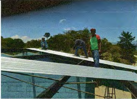
Foto 1: Cubierta de lámina para aulas
