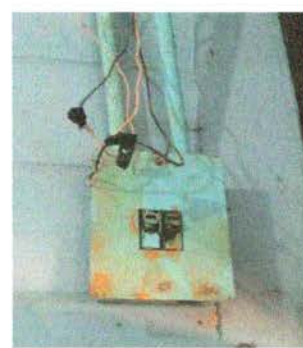
Foto 12: Sustrución de flipon
