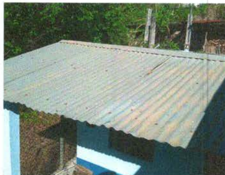
Foto 2: Cubierta de lámina para el modulo de cocina
