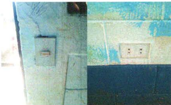
Foto 11: Sustrución de apagadores y tomacorrientes
