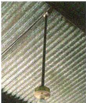
Foto 13: Sustitución de cableado y ducto electrico
