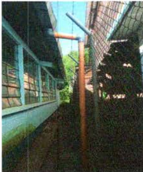
Foto 9: Sustrución de bajada de agua pluvial de tubo por tubo PVC 3"
