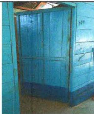
Foto 5: Sustitución de puerta de madera por metal
