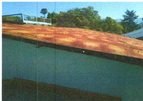
Foto 1: Cubierta de lámina para aulas
