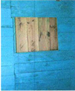
Foto 7: Sustrución de ventana de madera por metal mas vidrio
