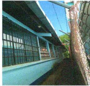
Foto 8: Sustitucion de canal de metal
