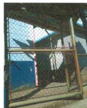
Foto 6: Sustitución de portón de metal
