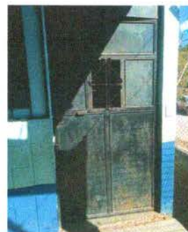
Foto 4: Mantenimiento a estructura de metal
