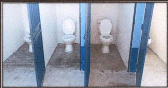
Fot 7: Finalización de aplicación de piso de concreto para baños
