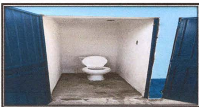
Foto 10: Finalización de instalación de inodoros
