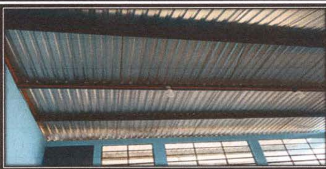
Foto 11: Finalización de la instalación del sistema eléctrico
