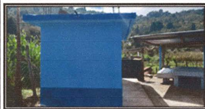
FOTO 16: Finalización de aplicación de repello de baños
