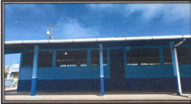
Foto 8: Finalización de colocación de canales y bajadas de agua pluvial
