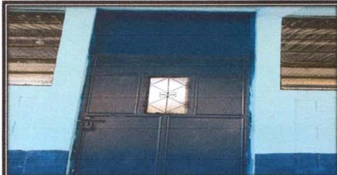
Foto 2: Finalización de mantenimiento de puertas de metal
