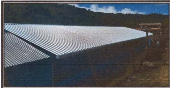
Foto 1: Finalización de instalación de lámina por lámina troquelada calibre 26
