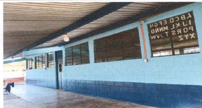
Foto9: Finalización de aplicación de pintura en muros exteriores e interiores
