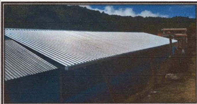
Foto15: Finalización de mano de obra de herrero
