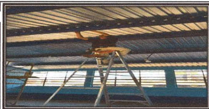
Foto 11: Instalación de sistema eléctrico durante el proceso de trabajo
