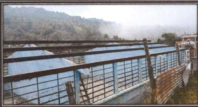
Foto15: Desinstalando el techo del centro educativo
