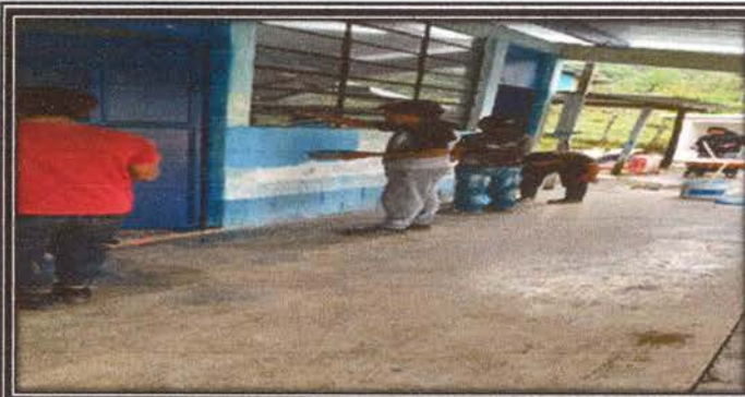
Foto9: Aplicación de pintura en muros exteriores e interiores durante el proceso de trabajo
