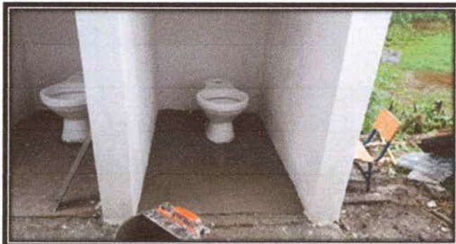
Fot 7: Aplicación de piso de concreto para baños durante proceso de trabajo
