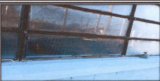
Foto 5: Colocación de vidrio transparente para ventana
