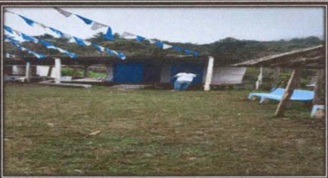
Foto 3: Trabajando para el lijado y pintado de puertas de metal de sanitarios
