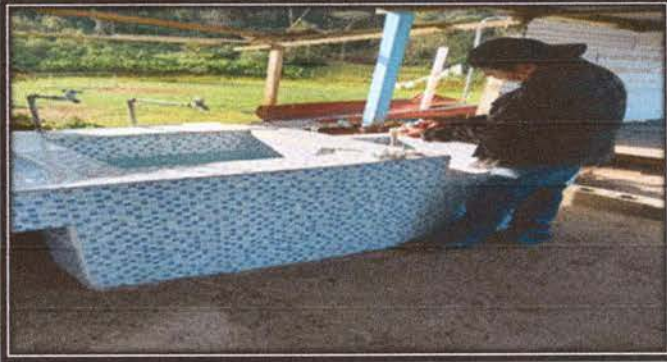
Fot 13: Sustrucción de llaves de plástico para chorros
