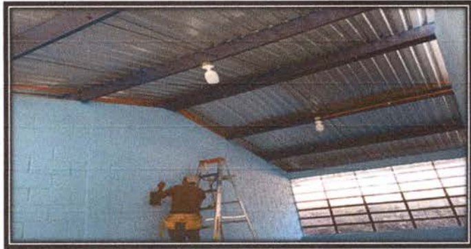
Foto 14: Trabajando para la instalación del sistema eléctrico
