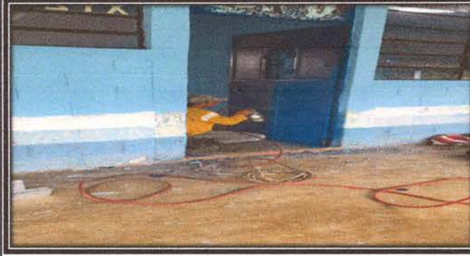
Foto 2: Trabajando en lijado y pintado de puertas de metal de aulas, cocina y dirección del establecimiento educativo
