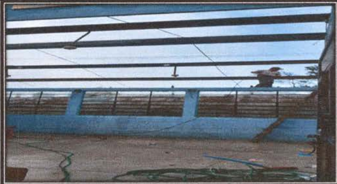
Foto1: Trabajando en sustitución de láminas por láminas troqueladas calibre 26
