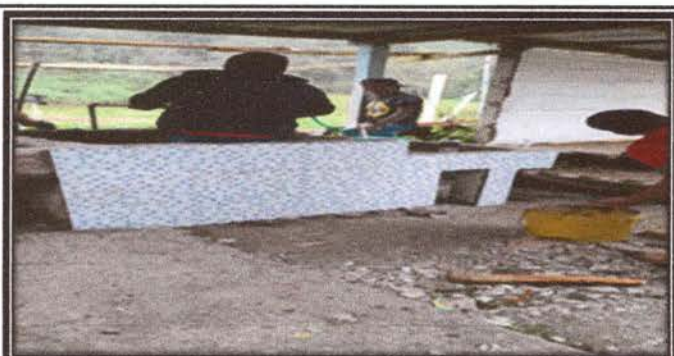
Foto 12: Aplicación de azulej para depósito de agua (pila)
