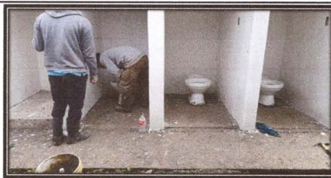
Foto 10: Colocación de inodoros
