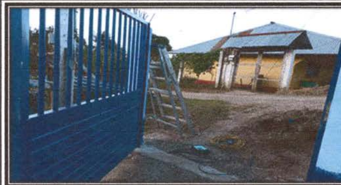
Foto 4: Proceso de instalación de porton
