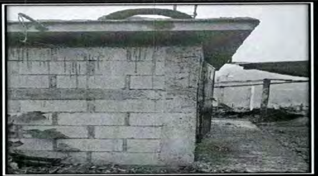
Foto 7: Mejoramiento de Repello (para proteger de la humedad) y mejoramiento de piso para baños
