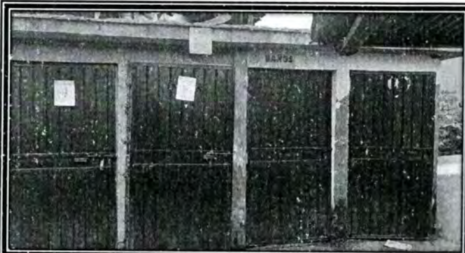
Foto 3: Mantenimiento de puertas de metal de sanitarios
