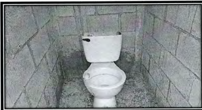
Foto 8: Sustitución de inodoros
