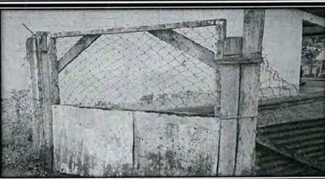
Foto 9: Sustitución de portón
