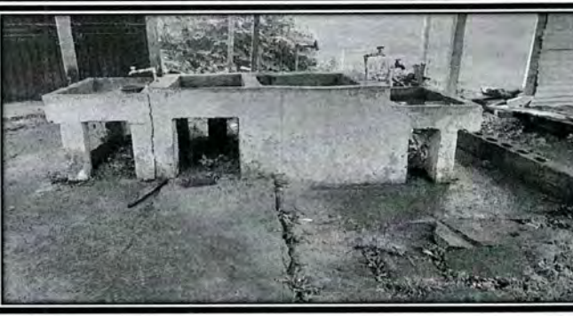
Foto 11: Mejoramiento (azulejo) en pilas
