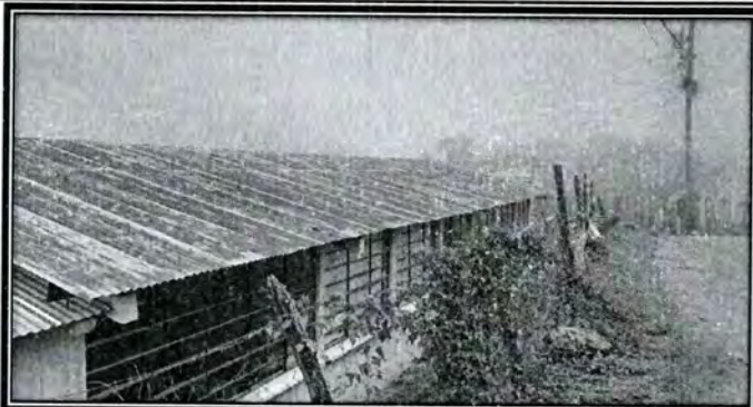
Foto 1: Sustrucción de cubierta de lámina, se encuentra en malas condiciones
