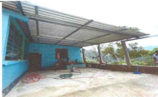
FOTO 8. Sustitucion de lamina y estructura de metal
