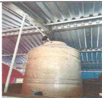
FOTO 9. Sustitucion de deposito de agua de 1500 tl.
