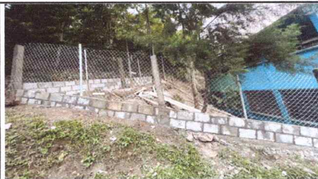
2. Reparacion de muro perimetral de block con tubo hg y malla galvanizada
