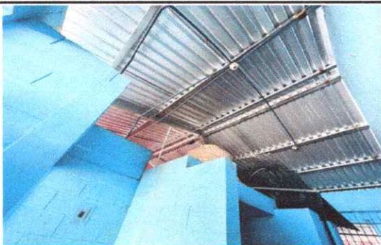
3.Sustitución de lámina, por lámina troquelada calibre 26
