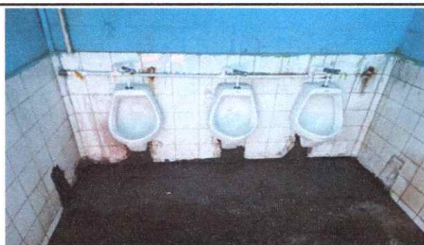
5. Sustitución de mingitorio
