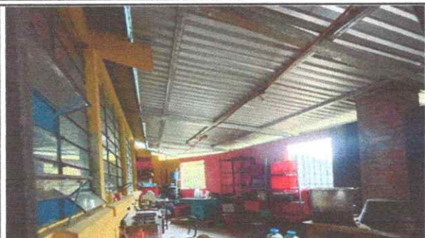
FOTO 7. Sustitucion de lamina y estructura de metal
