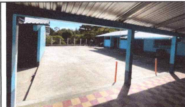
Foto 1: Sustitucion de piso de torta de concreto
