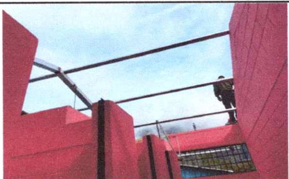
3. Sustitución de lámina, por lámina troquelada calibre 26
