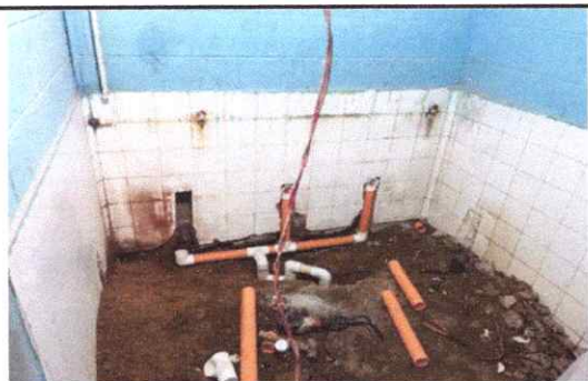
5. Sustitución de mingitorio
