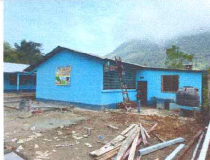
FOTO 8. Sustitución de lámina y estructura de metal
