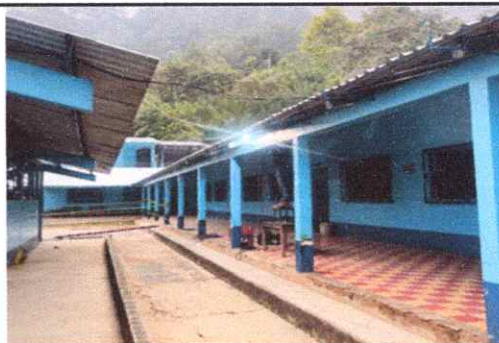
6. Sustitución de canal de metal
