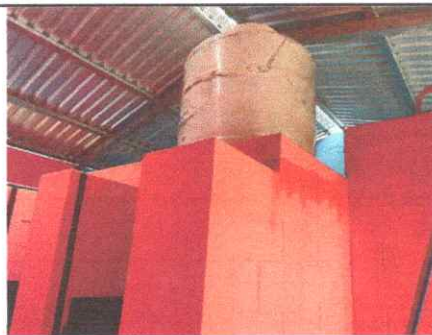
FOTO 9. Sustitución de depósito de agua de 1500 lt.
