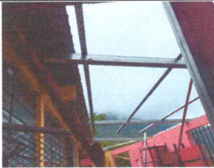
FOTO 7. Sustitución de lámina y estructura de metal
