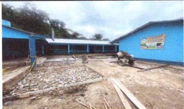
Foto 1: Sustitución de piso de torta de concreto
