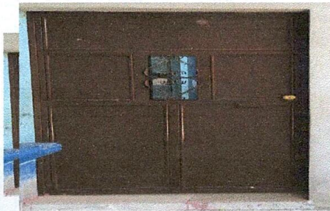
Foto 3: Colocación de puerta.
