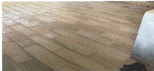
Foto 4: Sustitución de piso de concreto a piso de duelas.
