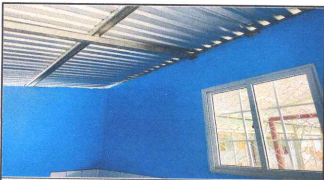
Foto 3: Sustitución de lámina y estructura en cocina; reparada totalmente
