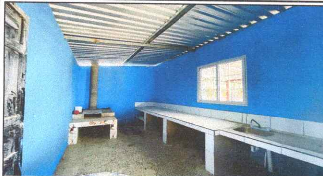
Foto1: Sustituciones de Fogón, Plancha, Piso y mesa de servicio reparado totalmente
