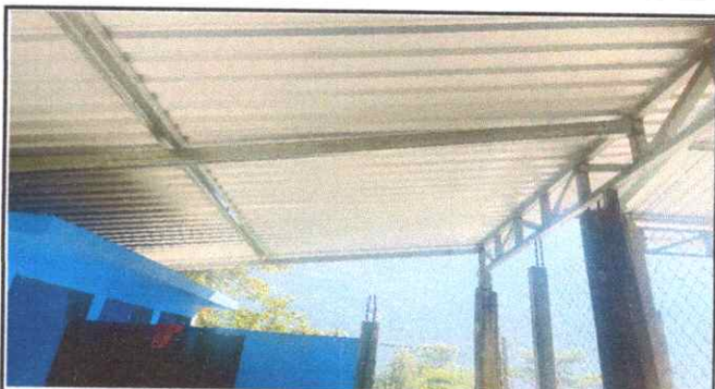
Foto 4: Módulo 2, Sustitución de estructura y lámina totalmente
