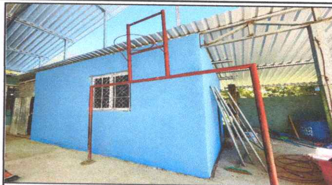
Foto 2: Sustitución de de ventanal, exterior techo reparado completamente
