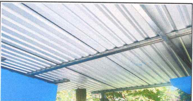
Foto 5: Sustitución completa de parte de estructura que ha sido reparada en muchas ocasiones
