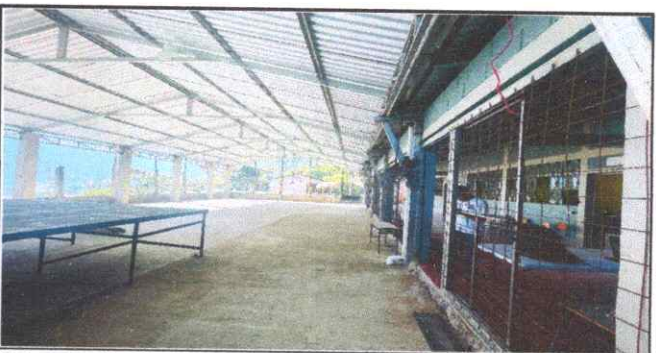
Foto 6: Sustitución completa de cubierta baja, reparación de filtraciones ante el exceso de Sol y lluvia, reparación de estructura demasiado delgada, sustitución de postes falsos y reparación de piso rajado
