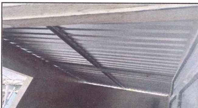
Foto 3: lámina deteriorada, estructura de madera fase final de vida; en proceso
