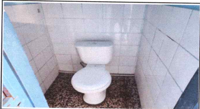
Foto 4: Sustitución de inodoro
