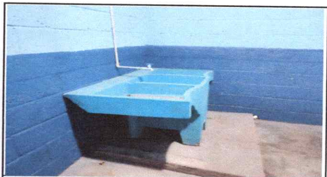
Foto 6: Sustitución de pila de cemento de dos lavaderos
