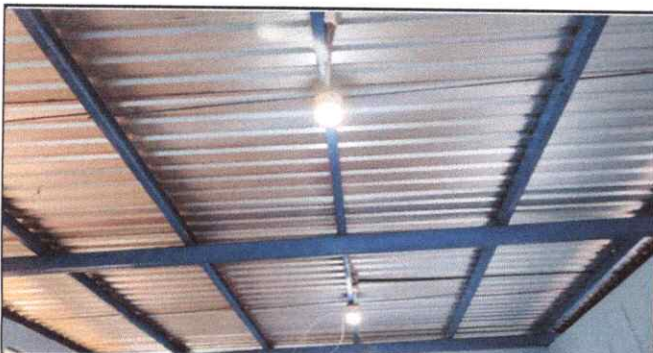
Foto 5: Sustitución de focos ahorradores
