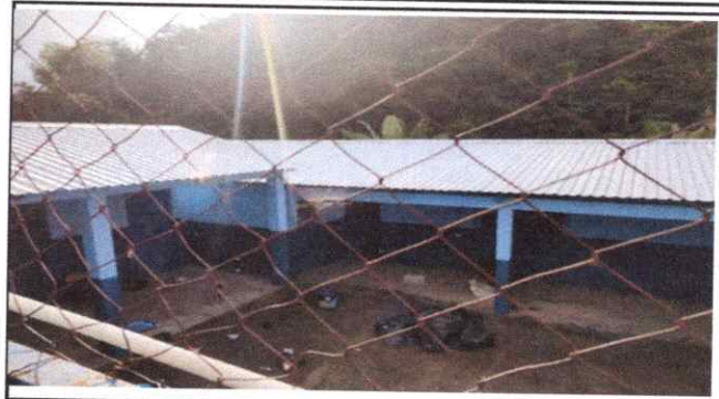
Foto 2: Sustitución de lámina, por lámina troquelada
