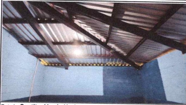
Foto1: Sustitución de lámina, por lámina troquelada
