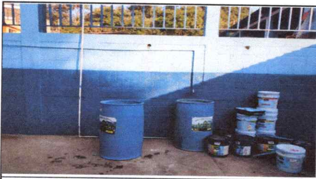
Foto 3: Pintura en muros exteriores e interiores
