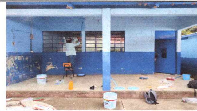
Foto 3: Pintura en muros exteriores e interiores
