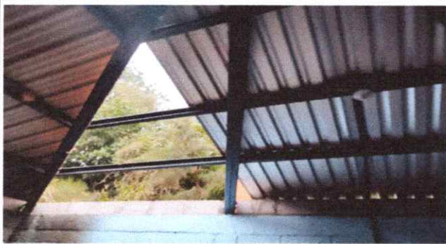
Foto 1: Sustitución de lámina, por lámina troquelada
