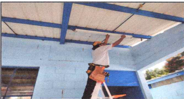
Foto 5: Sustitución de focos ahorradores
