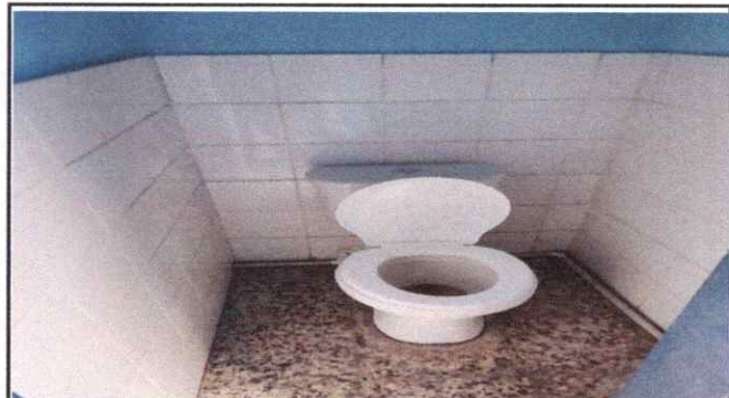
Foto 4: Sustitución de inodoro
