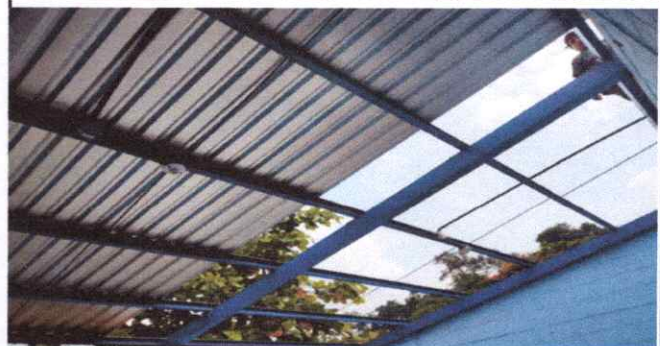
Foto 2: Sustitución de lámina, por lámina troquelada
