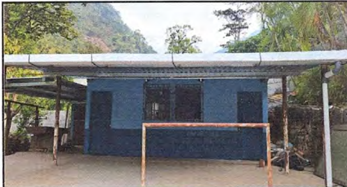
Foto 10: Instalación terminada de canales de alto caudal y tubos de PVC para bajada de aguas pluviales ambiente de cocina, bodegas y escenario. Pintura terminada.
