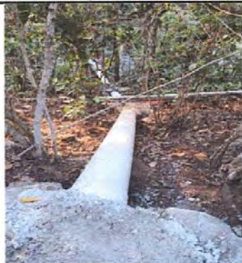
Foto 8: Instalación terminada de Tubería PVC línea principal de aguas pluviales.
