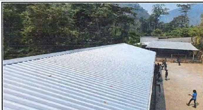
Foto 1: Instalación terminada de techo de lámina en ambiente de dirección y aulas.
