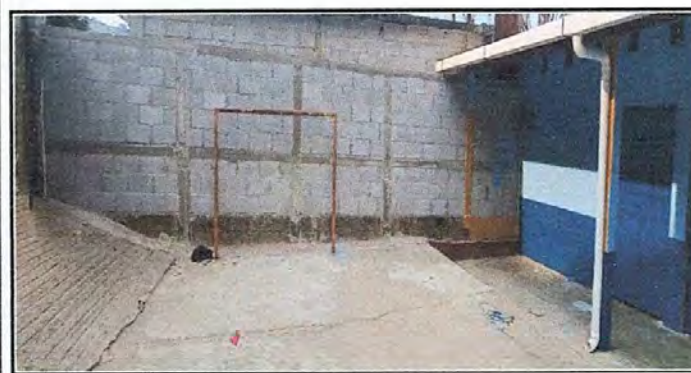
Foto 5: Muro perimetral con material de block, hierro y cemento, reparación de columnas en mal estado. TERMINADO.
