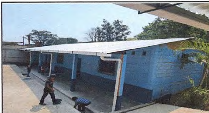
Foto 9: Instalación terminada de canales de alto caudal y tubos de PVC para bajada de aguas pluviales ambiente de dirección y aulas. Pintura terminada.
