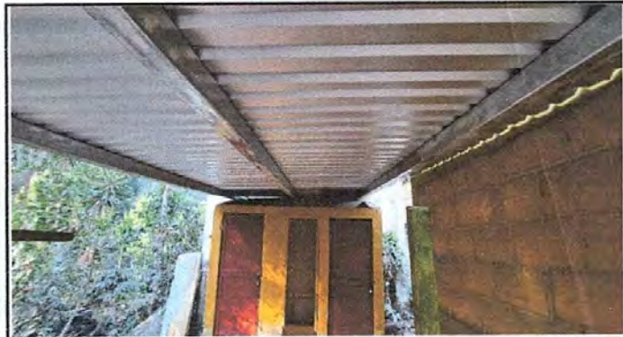
Foto 4: Instalación terminada de lámina y tubos de metal en ambiente de pila y baños.
