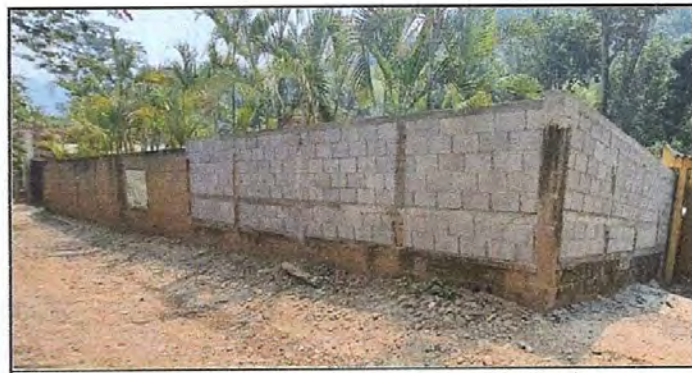
Foto 6: Muro perimetral con material de block, hierro y cemento, reparación de columnas en mal estado. TERMINADO.
