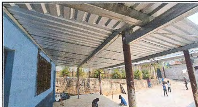
Foto 3: Instalación terminada de lámina y tubos de metal en ambiente de escenario.
