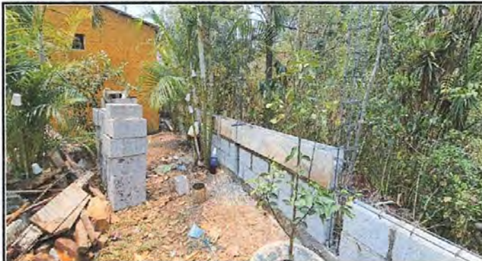
Foto 7: Instalación de muro perimetral con material de block, hierro y cemento. Reparación de columnas en mal estado.
