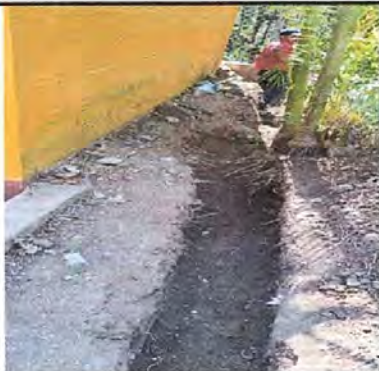
Foto 9: Zangeado para instalación de tubos de drenaje para aguas pluviales
