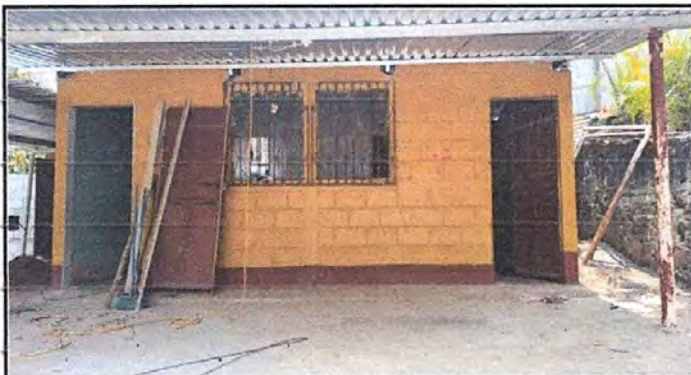
Foto 15: Desinstalación de puertas en cocina y bodega.
