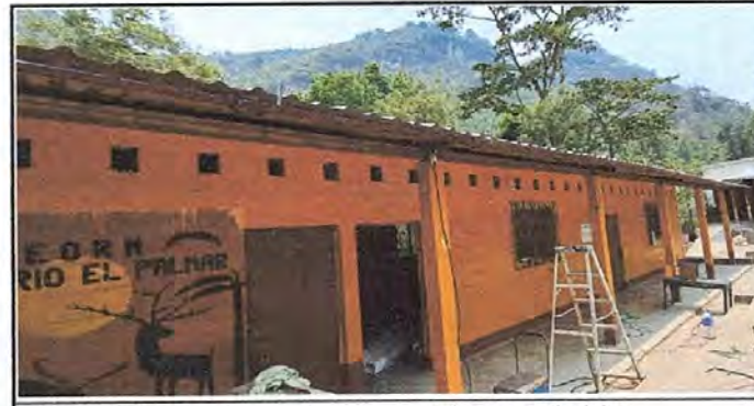
Foto 12: Instalación de soporte para canal de aguas pluviales.
