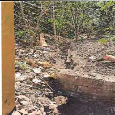
Foto 10: Zangeado para sustituir tubos de drenaje para aguas pluviales.
