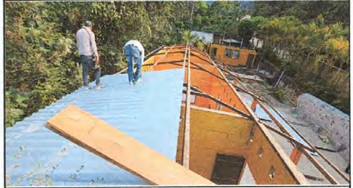
Foto 2: Colocación de techo de lámina en los ambientes de 2 aulas y dirección.
