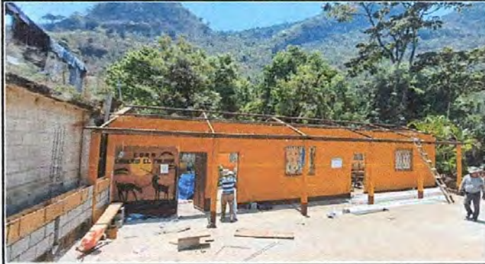
Foto 1: Desmontaje de techo de lámina de los ambientes de 2 aulas y dirección.
