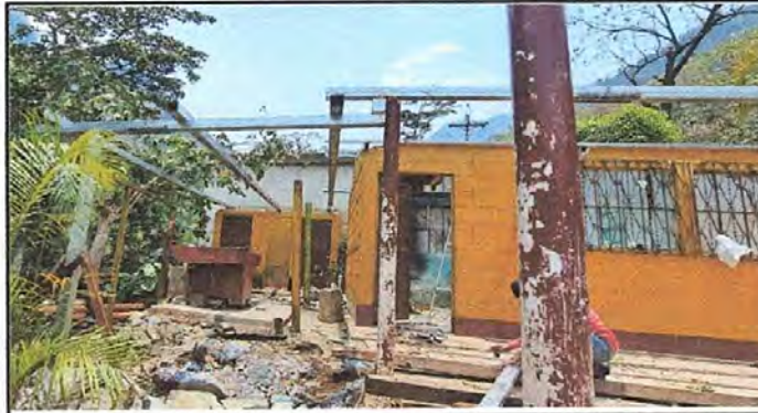
Foto 8: Instalación de tubos de metal para techo en área de pila y baños.
