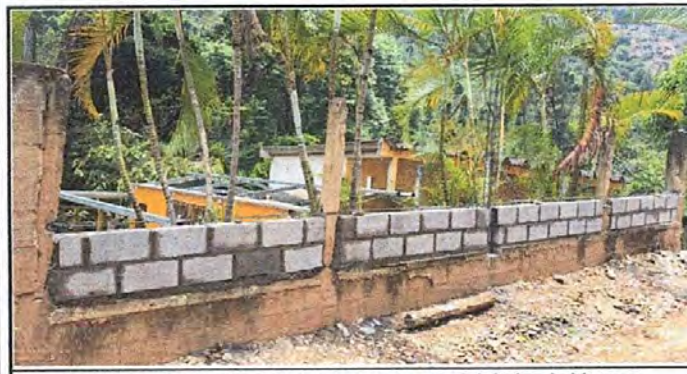
Foto 5: Instalación de muro perimetral con material de block, hierro y cemento, reparación de columnas en mal estado.
